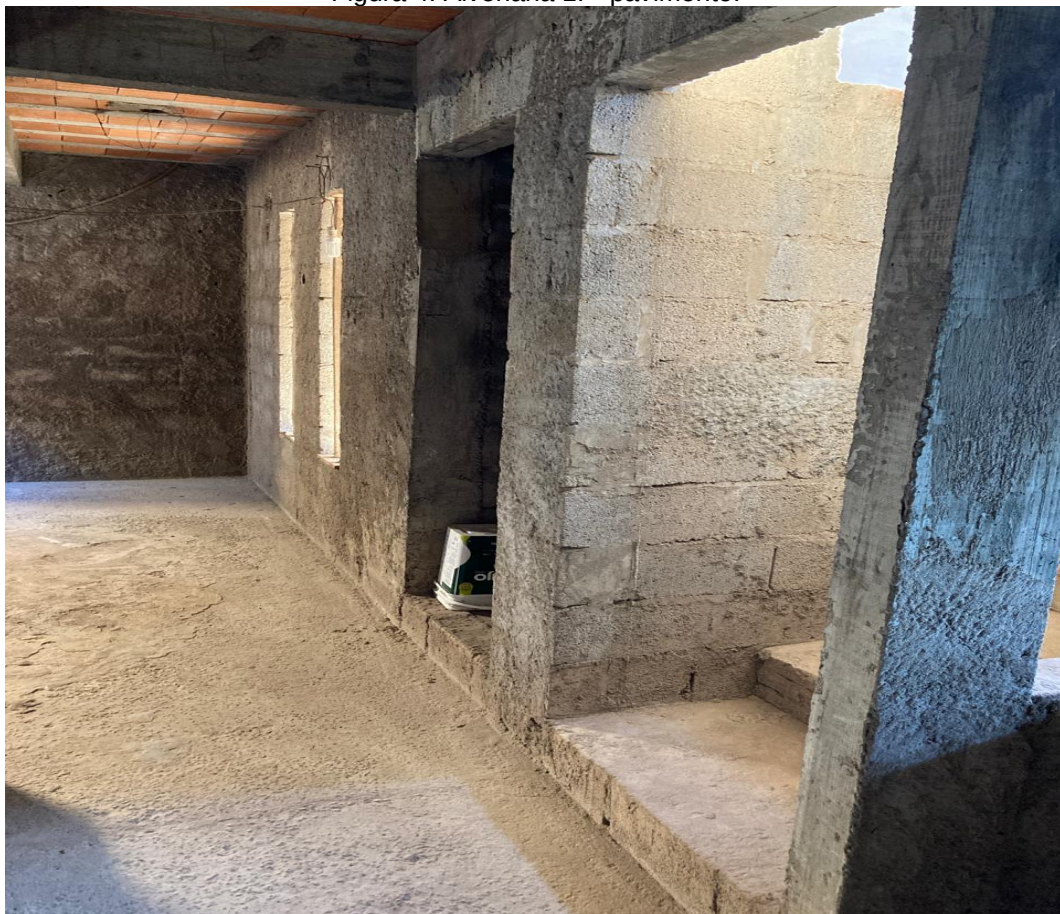
Figura 4: Alvenaria 1.º pavimento.
