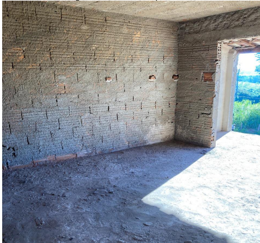
Figura 5: Alvenaria 2.º pavimento.
