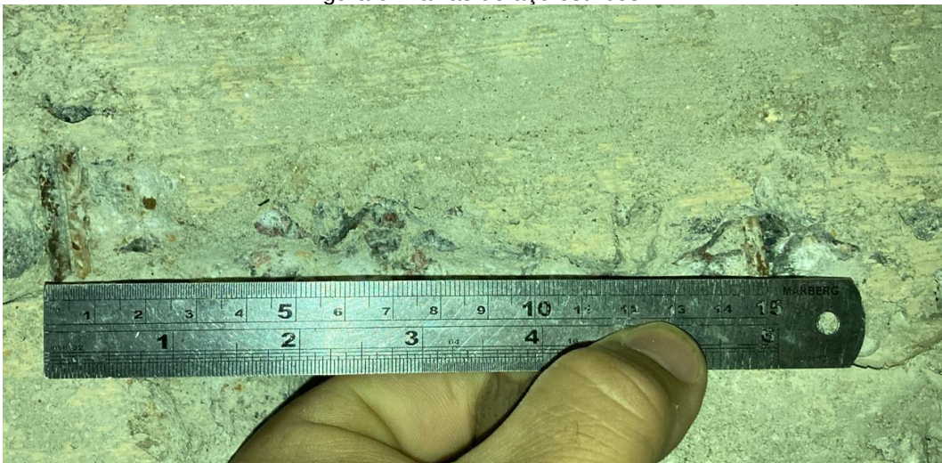
Figura 9: Barras de aço estribos.
