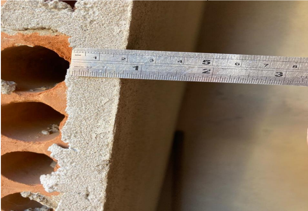
Figura 12: Espessura de revestimento por face.
