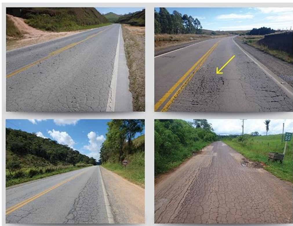
Figura 2 - Trincas Couro de Jacaré
