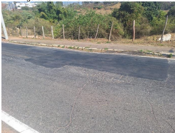
Figura 25 – Remendo Trecho 03
