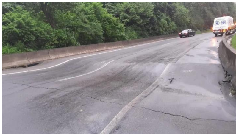
Figura 9 - Ondulação em Pavimento
