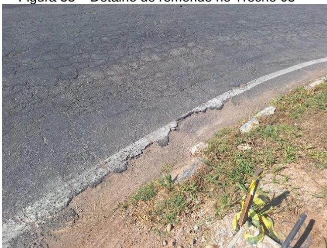
Figura 53 – Detalhe de remendo no Trecho 03
