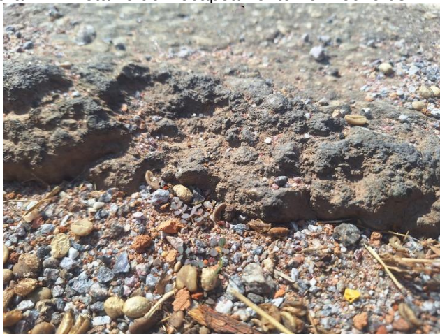
Figura 27 – Detalhe do Recapeamento no Trecho 03
