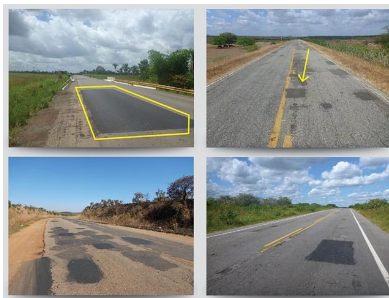
Figura 12 - Remendo em Pavimento
