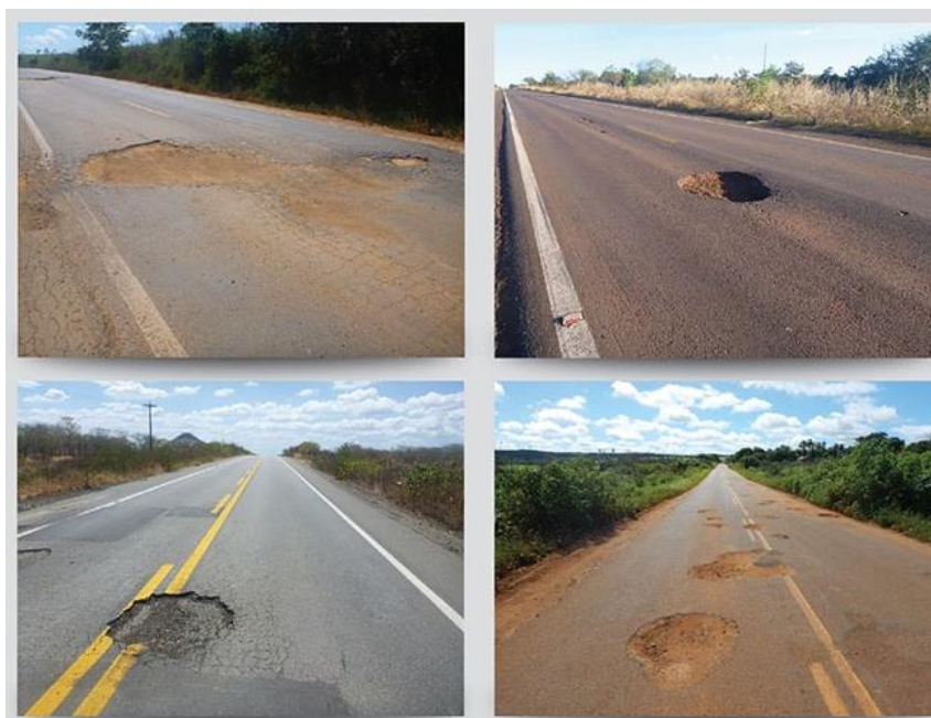
Figura 10 - Panela em Pavimento
