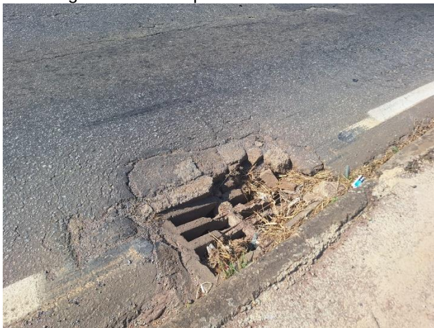
Figura 26 – Recapeamento no Trecho 03
