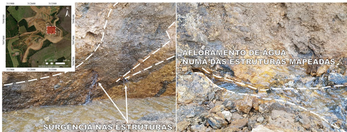
Figura 58 - Percolação de água em superfície.
