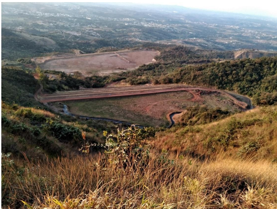
Figura 23 - Vista superior da Barragem B2
