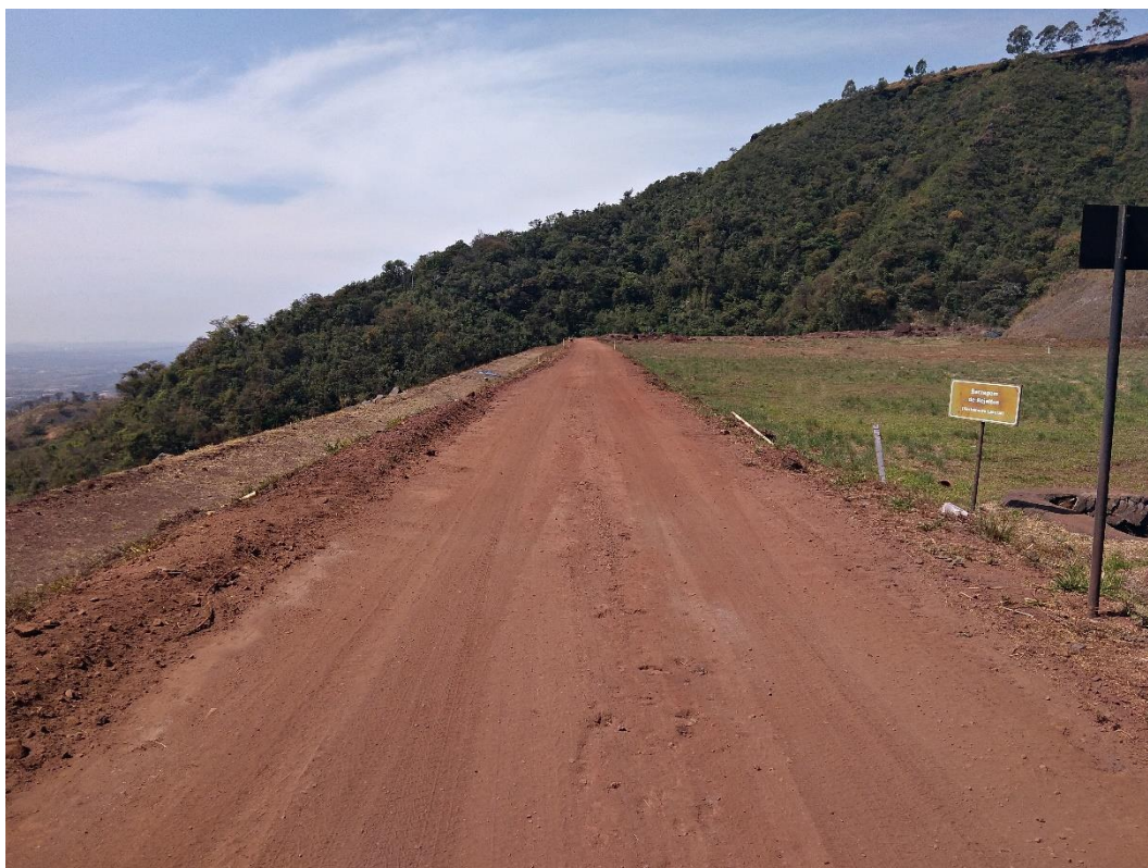
Figura 20 - Crista da Barragem B2
