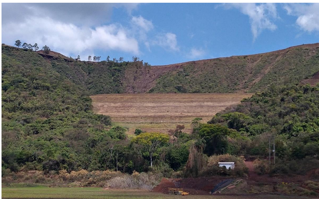
Figura 21 - Vista frontal da Barragem B2
