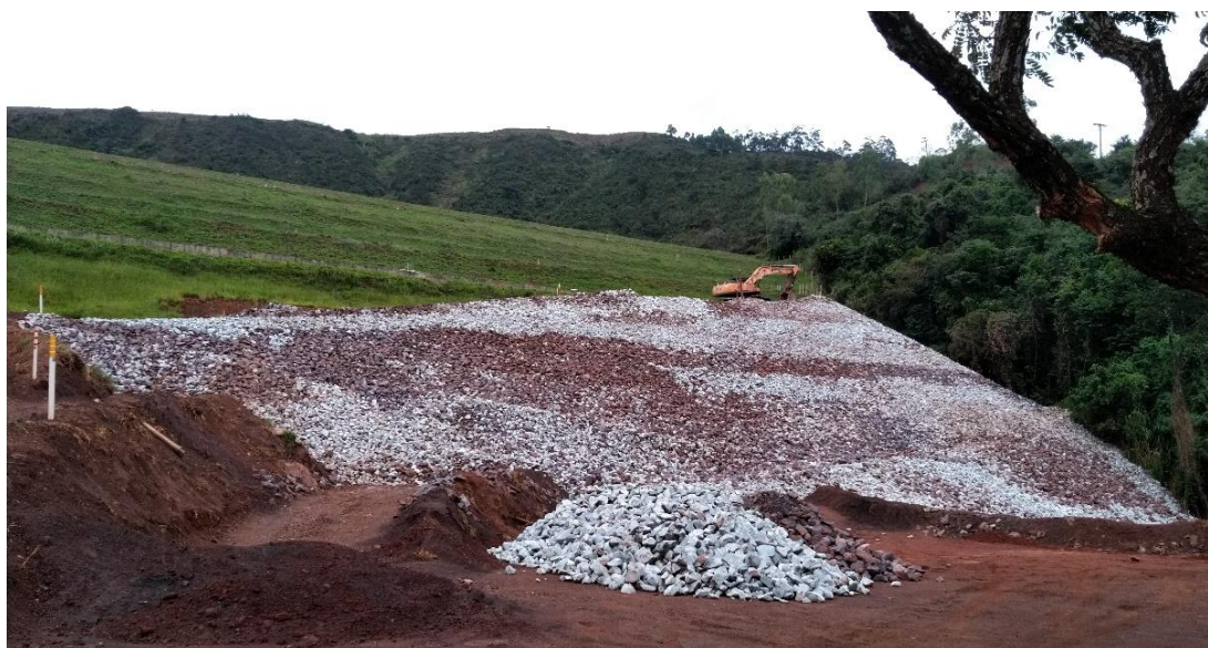
Figura 33 - Reforço da Barragem B2
