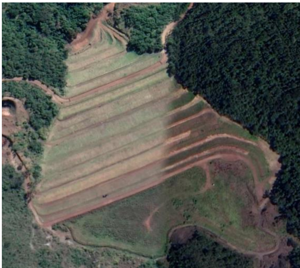
Figura 24 - Vista elevada da Barragem B2
