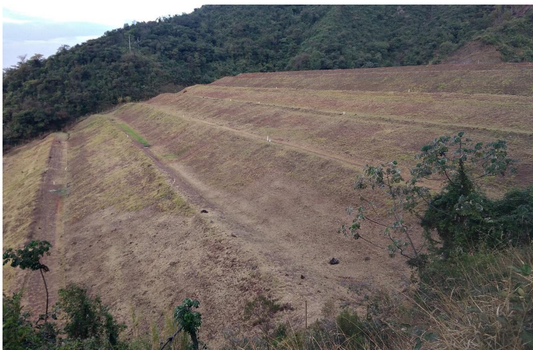
Figura 19 - Vista lateral da Barragem B2
