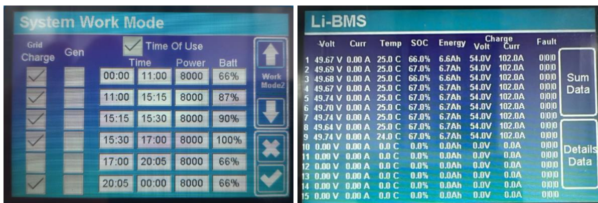
Figura 7 – Programação diária e estado de carga das baterias do data center do CEFET-MG
