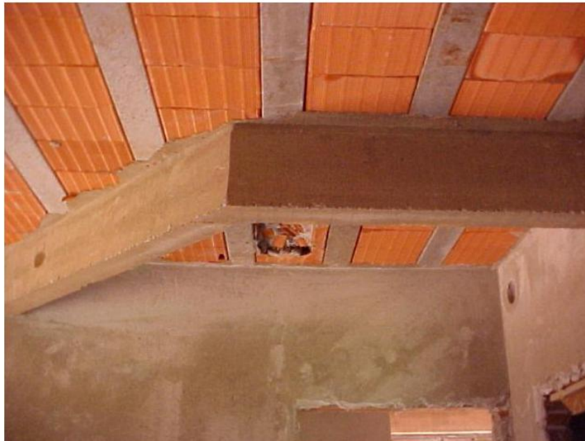
Figura 3 - Viga com mudança de direção, devendo considerar momentos de torção.
