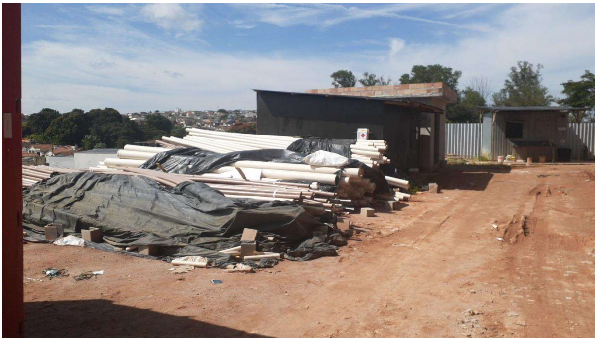
Figura 12 – Área de depósito fora da aérea de circulação
