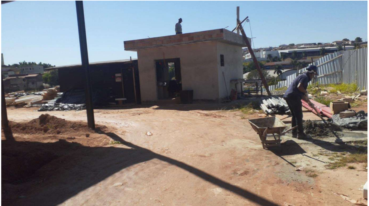
Figura 16 – Execução da atividade laboral na obra
