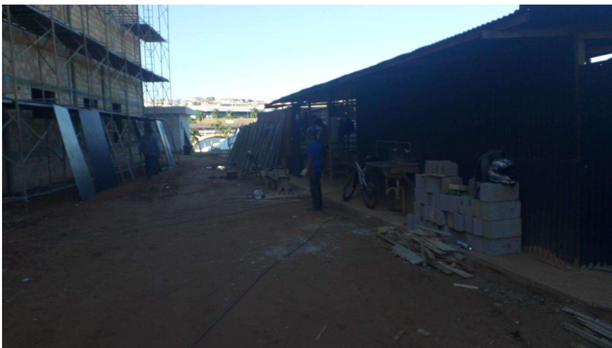
Figura 21 – Andaime, materiais e EPI
