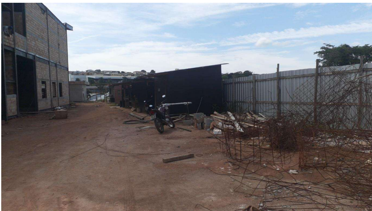
Figura 13 – Área de descarte de ferragens e área de depósito de fôrmas.
