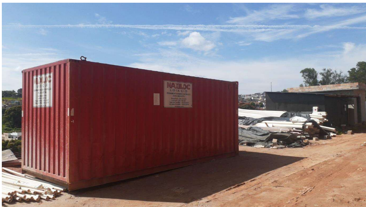
Figura 11 – Contêiner usado somente para depósito de equipamentos e ferramentas
