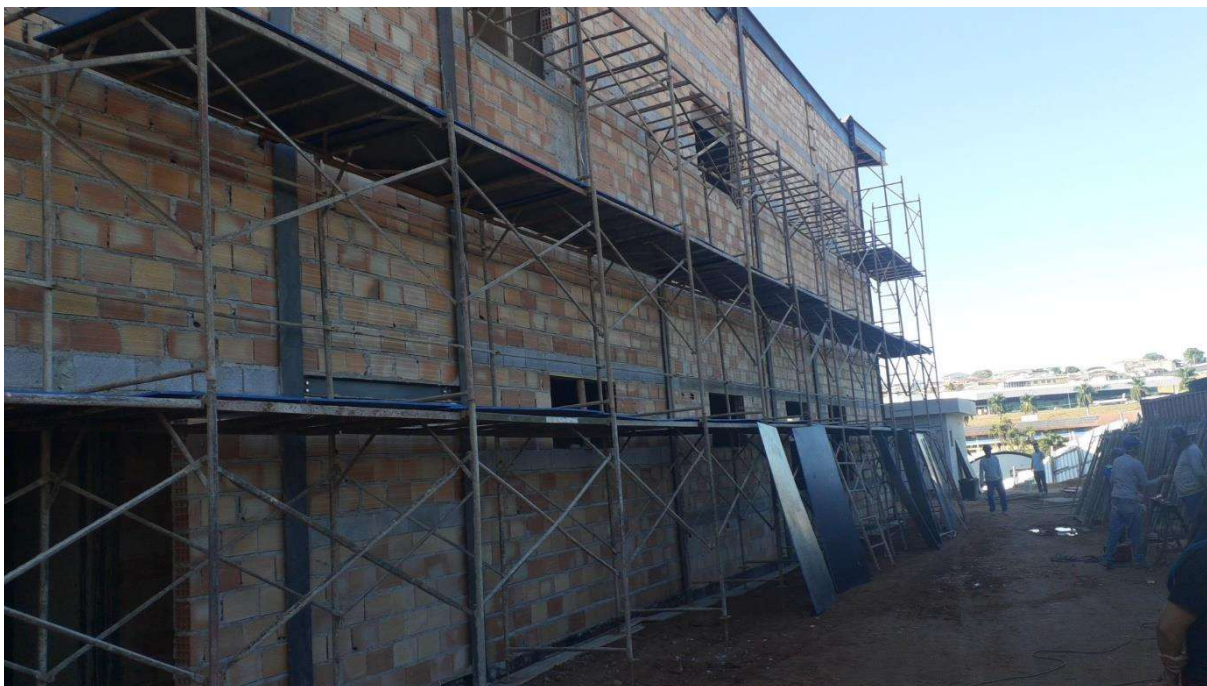
Figura 20 – Andaime cobrindo a extensão total da parede externa
