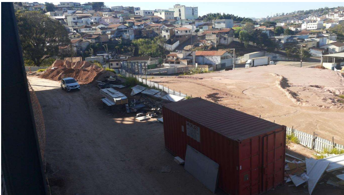
Figura 18 – Contêiner para depósito, área aberta e área de circulação
