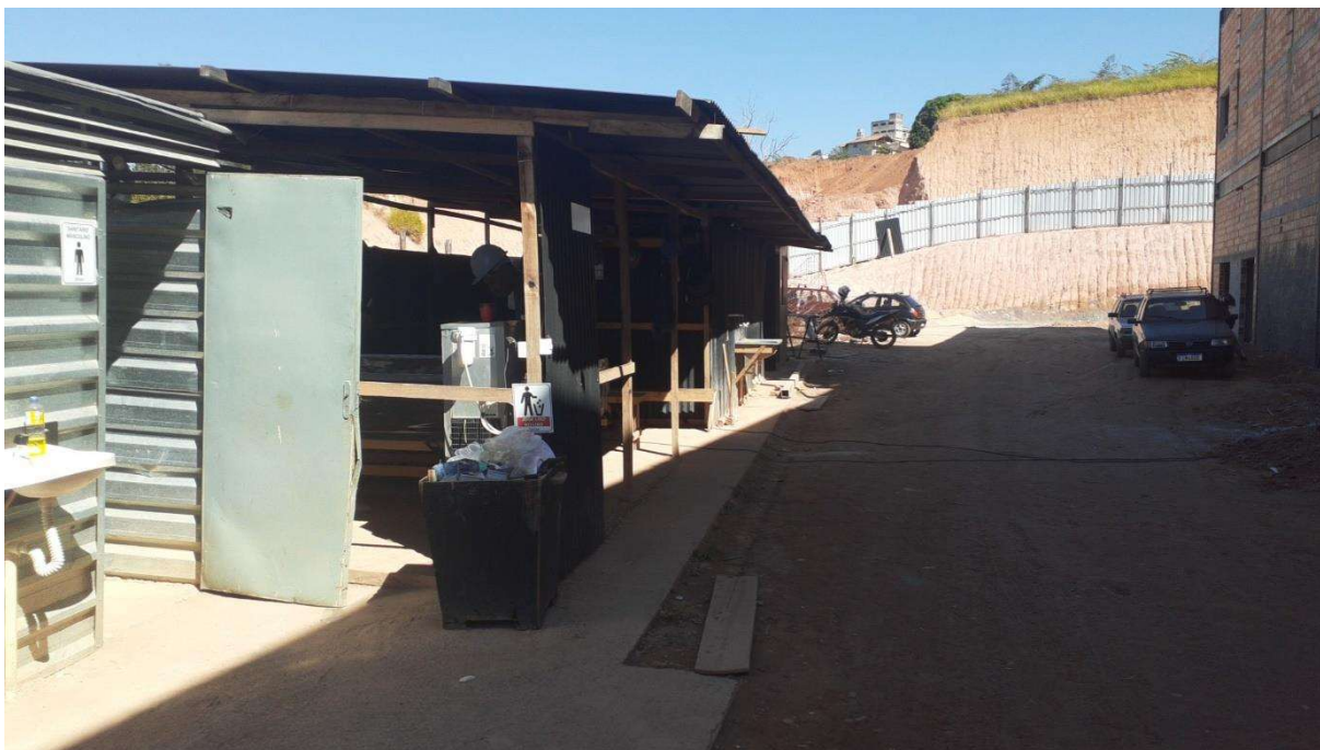
Figura 14 – Área de vivência com banheiro, lavatório, refeitório e tanque com água
