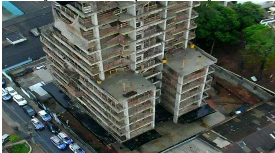
Figura 7 – Obra em construção no centro de Varginha-MG
