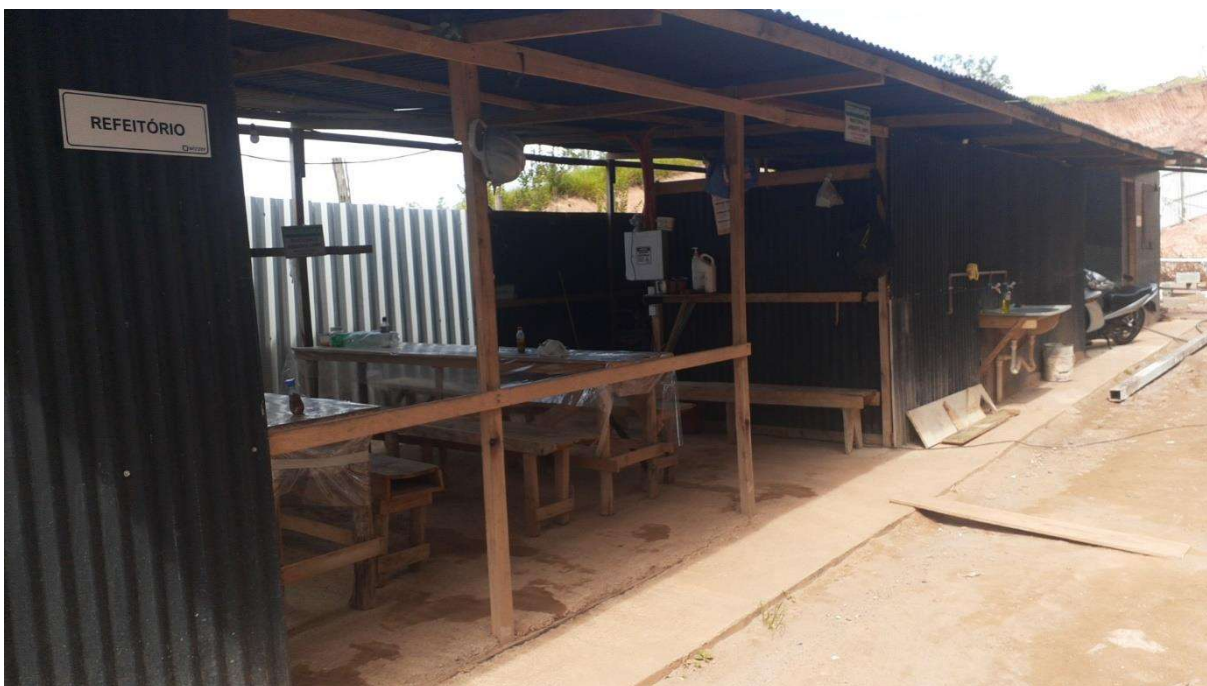
Figura 15 - Área de vivência com refeitório e tanque com água
