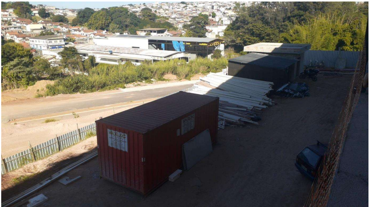
Figura 17 – Contêiner para depósito, área aberta e coberta para depósito e escritório
