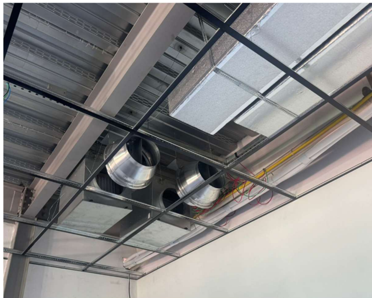
Figura 21 – Dutos MPU pré-instalados em ACI-315, painéis de alumínio pré-isolados com espuma de poliuretano
