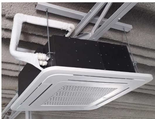
Figura 14 – Cassete de 4 vias instalado em ambiente comercial, modelo adotado para Hall, Salão de Estudos e Acervo
