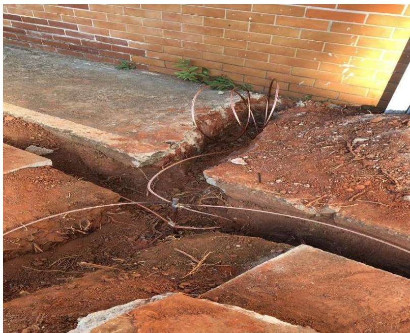
Figura 16 - Composição da Malha de aterramento (Autor)
