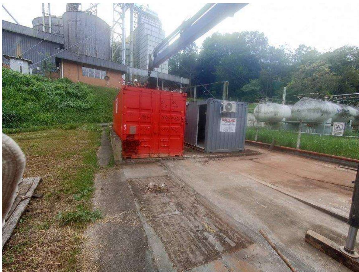
Figura 23 - Montagem do canteiro de obra (Autor)
