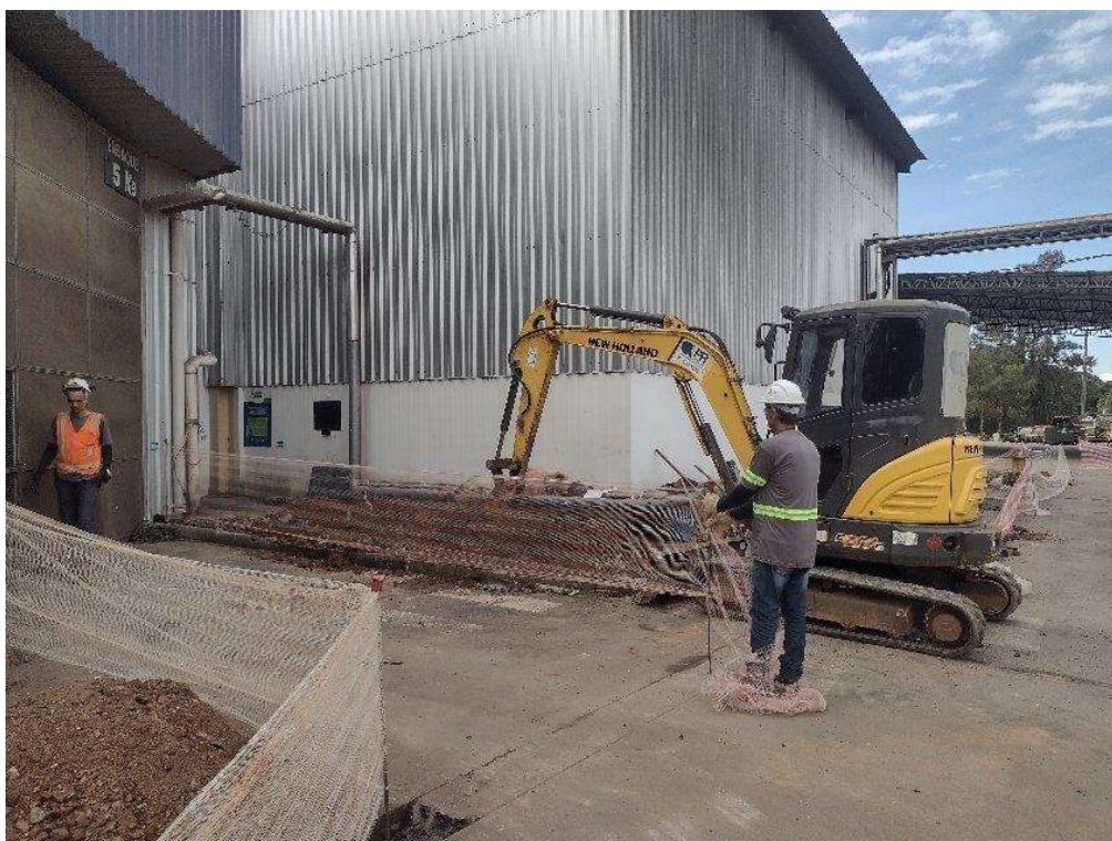
Figura 15 - Escavação Mecanizada (Autor)
