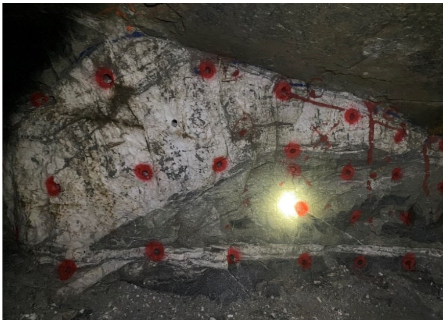
Figura 39 - Superfície da frente de trabalho após o processo de perfuração ser realizado
