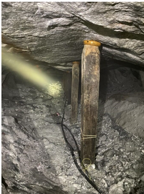
Figura 26 - Esteios de madeira com jackpots instalados para sustentação do teto nas frentes de trabalho
