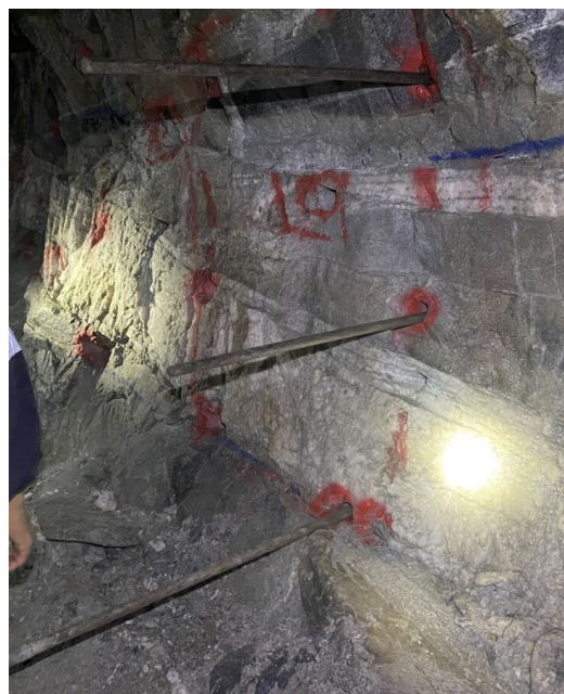
Figura 68 - Verificação do paralelismo e da profundidade dos furos realizados
