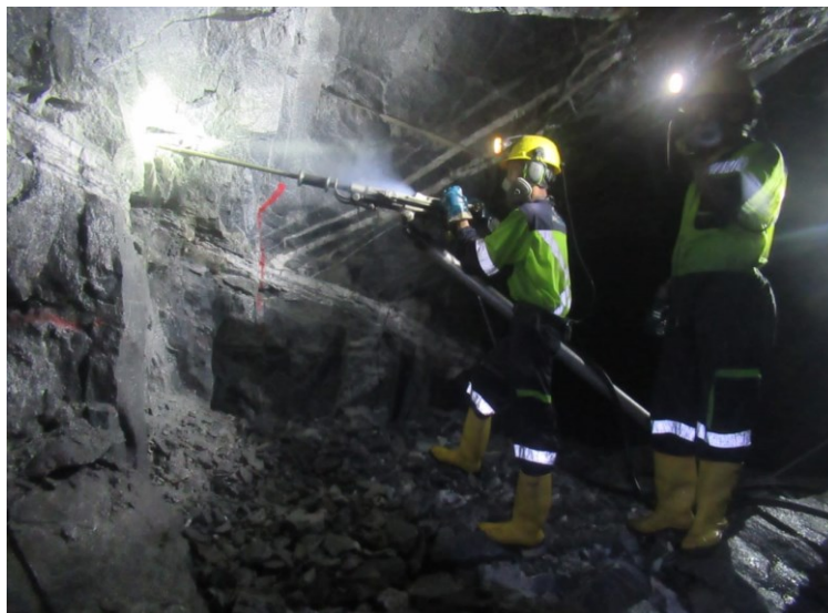
Figura 19 - Machinero e auxiliar de machinero executando a perfuração da rocha utilizando equipamento do tipo jackleg
