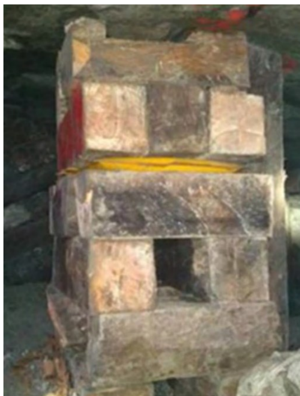
Figura 30 - Fogueira pré-tensionada com o dispositivo jackpack para auxiliar o processo de sustentação do teto
