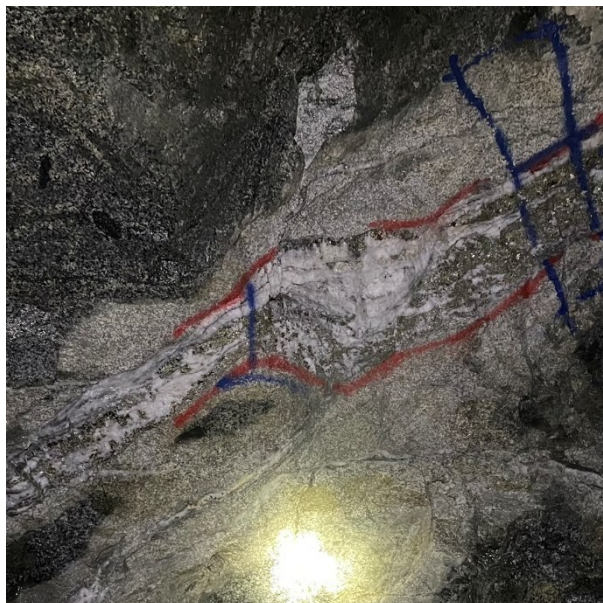
Figura 47 - Delimitação do veio nas frentes de trabalho para medição da altura de corte e largura dos veios
