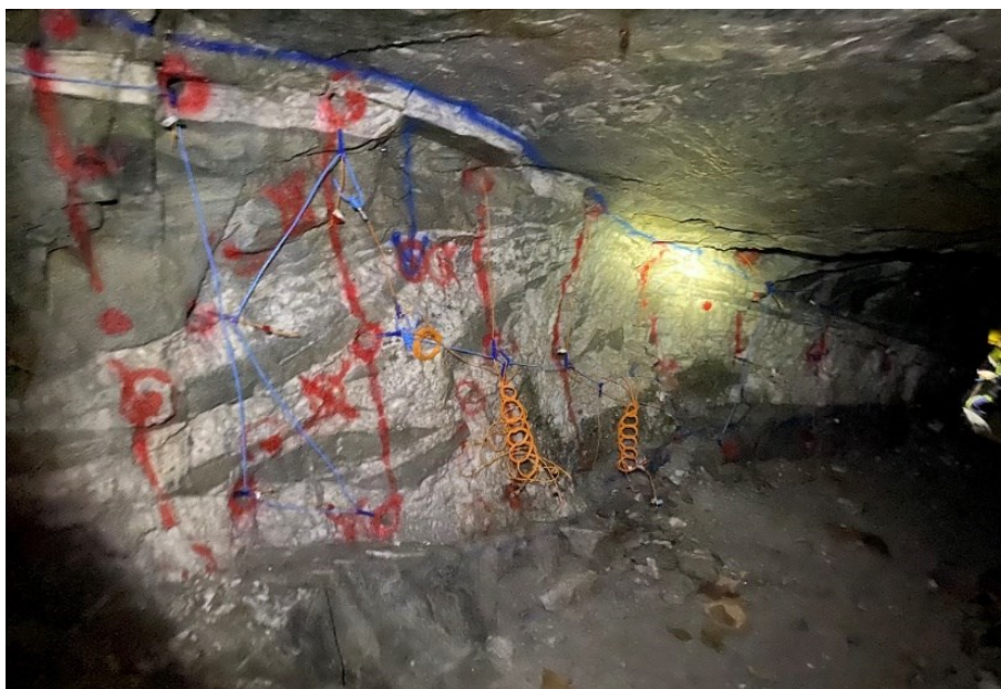
Figura 40 - Instalação dos dispositivos de detonação nos furos realizados ao longo do painel
