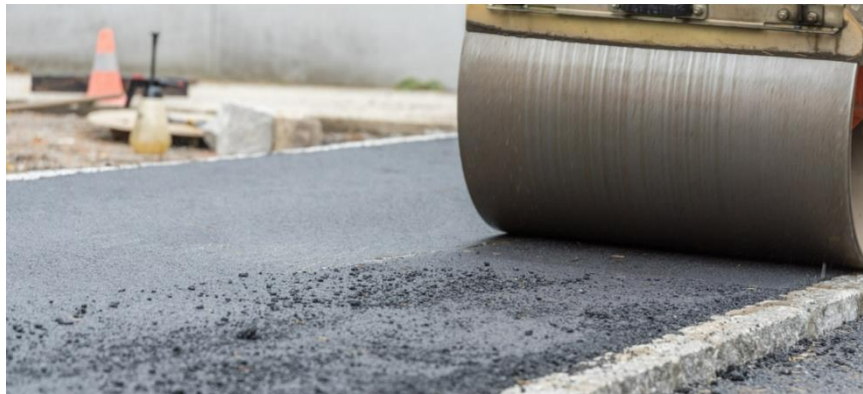
Figura 3 – Compressão de lama asfáltica
