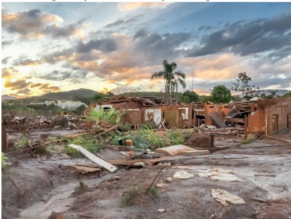
Figura 12 - Impactos em decorrência do rompimento da barragem de Fundão.
