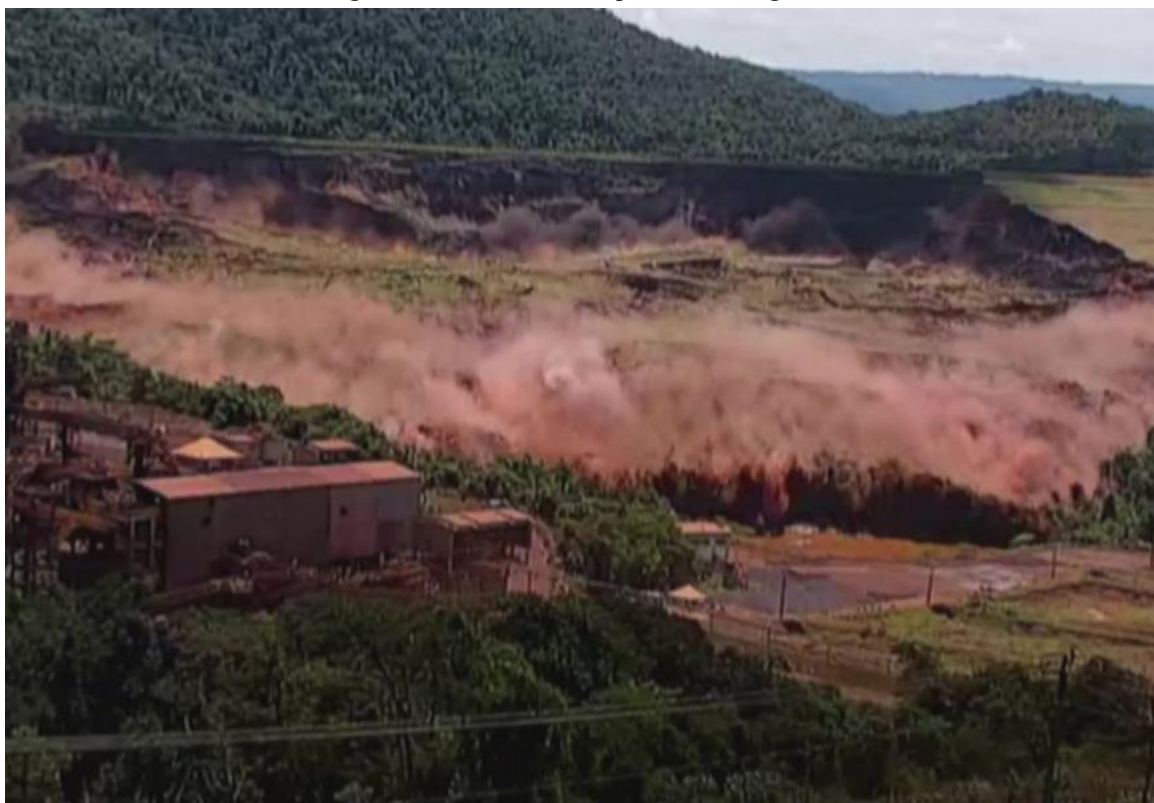
Figura 14 - Momento da ruptura da Barragem 1.
