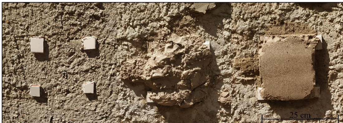
Figura 23 - Aplicação em parede
