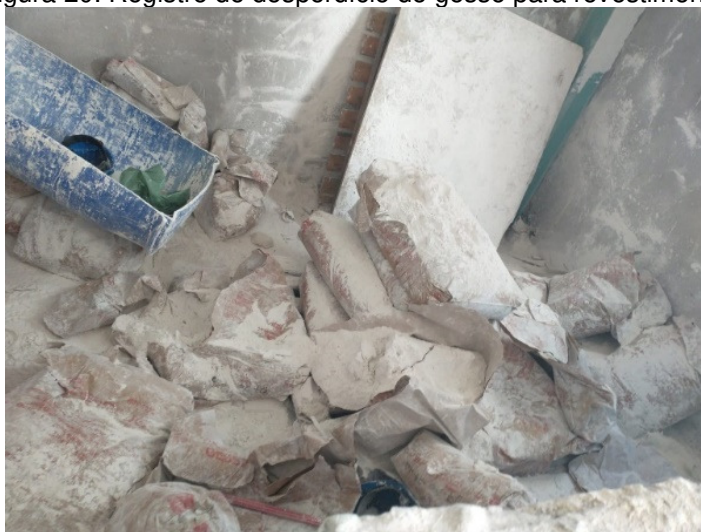
Figura 20: Registro de desperdício de gesso para revestimento.
