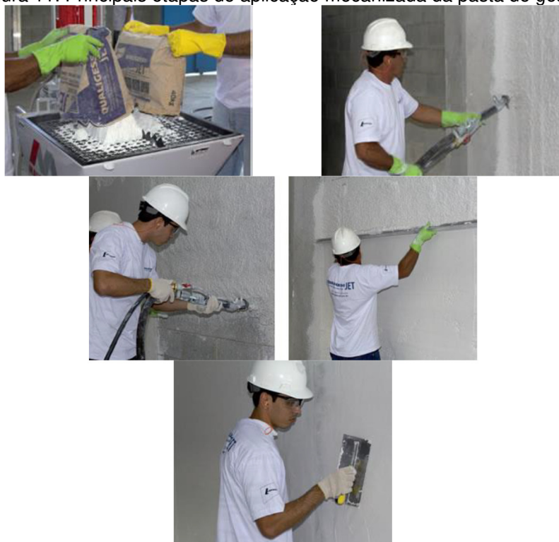
Figura 11: Principais etapas de aplicação mecanizada da pasta de gesso.
