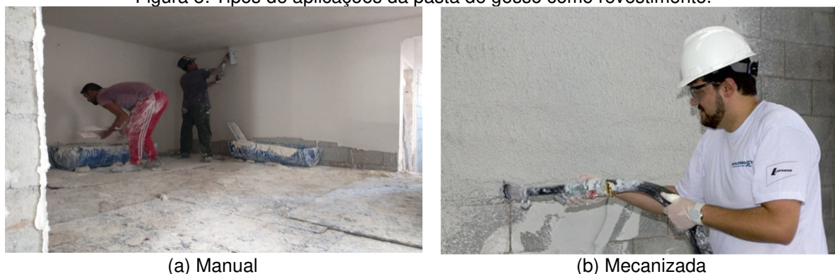
Figura 8: Tipos de aplicações da pasta de gesso como revestimento.
