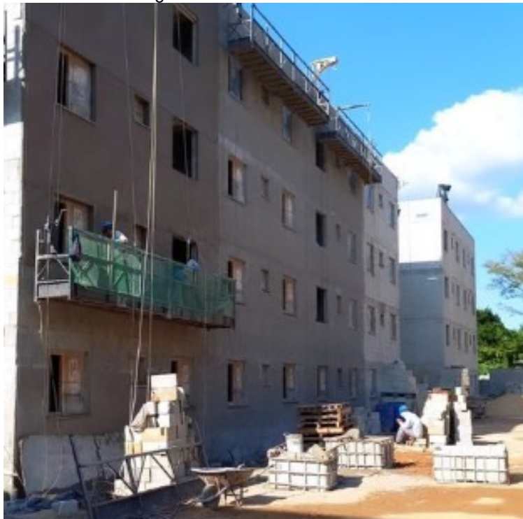
Figura 19: Alvenaria estrutural.
