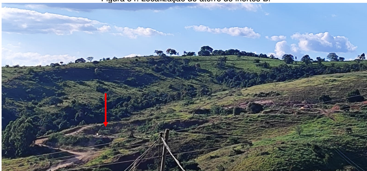
Figura 34: Localização do aterro de inertes B.
