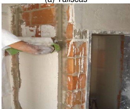
(c) Aplicação manual da pasta de gesso entre as guias
