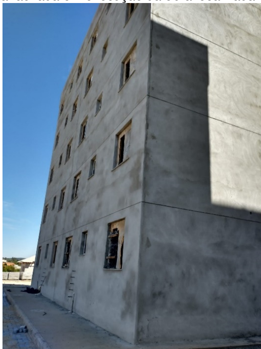
Figura 21: Vista da fachada em execução da obra localizada em Três Corações.
