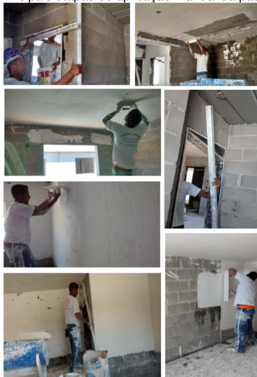
Figura 10: Principais etapas de aplicação manual da pasta de gesso.
