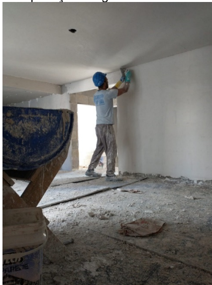
Figura 25 : Aplicação do gesso no Park Sion
