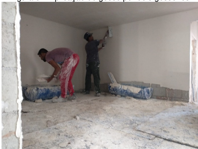
Figura 31: Aplicação de gesso por dois gesseiros.
