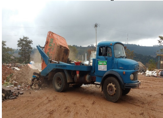
(a) Recebimento de caçamba e triagem de resíduos
