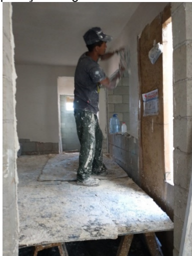
Figura 30: Aplicação de gesso na obra de Três Corações.
