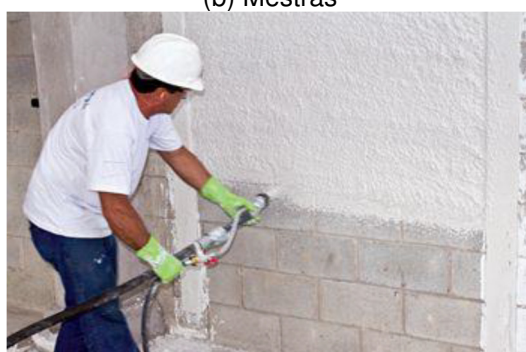
(d) Aplicação mecanizada da pasta de gesso entre as guias
