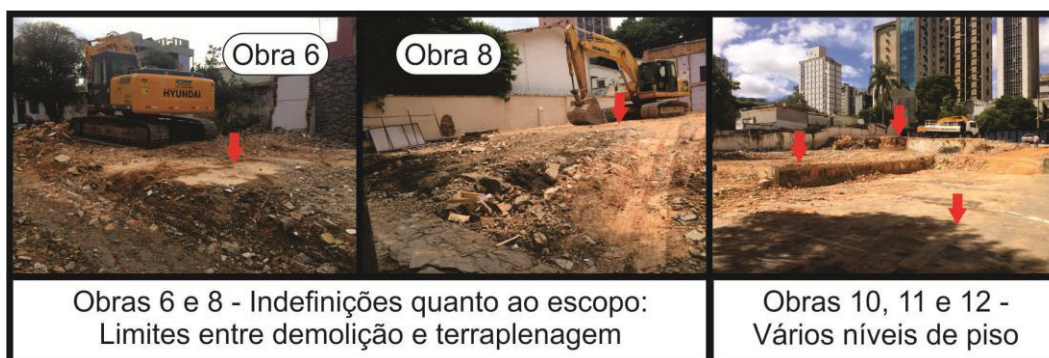
Figura 32 - Vários níveis de pisos de obra e indefinições quanto o escopo da obra
