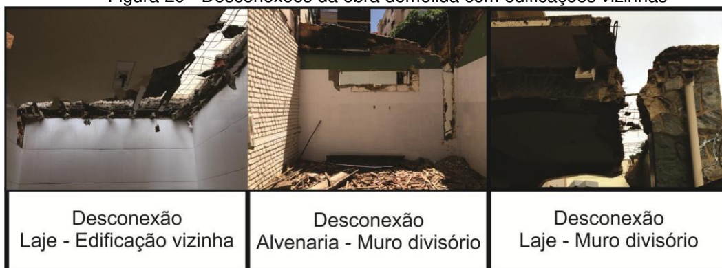
Figura 29 - Desconexões da obra demolida com edificações vizinhas
