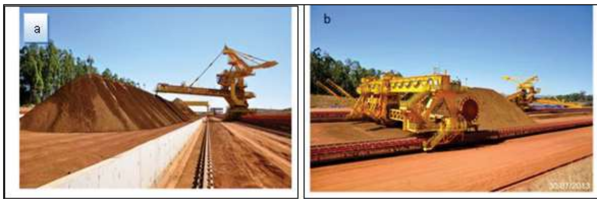
Figura 3 a e b: Pátio de Homogeneização mostrando (a) empilhamento de minério e (b) retomada
