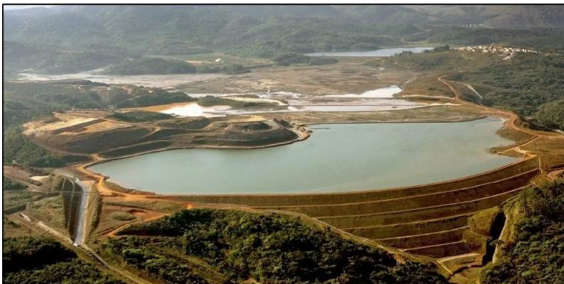
Figura 1 – Vista aérea da Barragem Casa de Pedra, Congonhas (MG).
