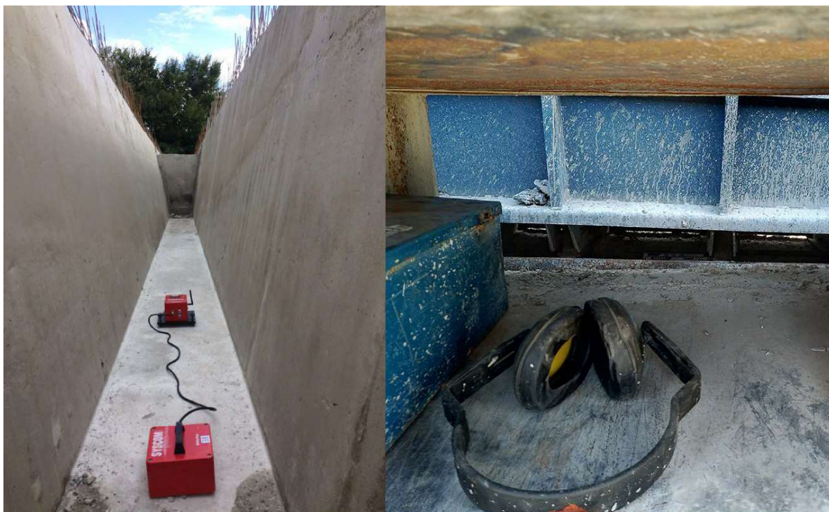
Figura 10 - (a) Conjunto de aquisição posicionado no fundo da viga (b) Ao fundo as vigas metálicas apoiadas no solo
