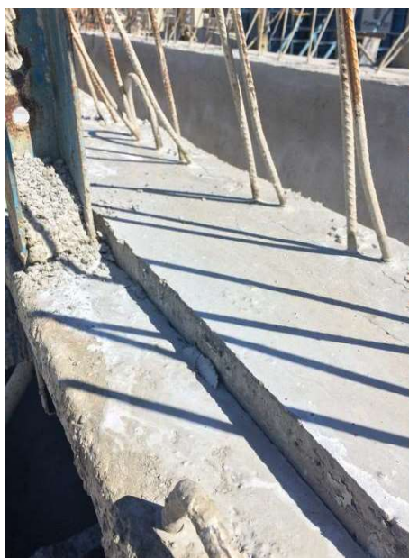
Figura 8 - (a) Contraflecha da viga (b) Viga sendo içada
