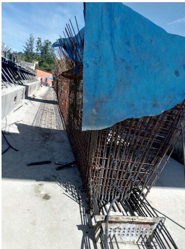
Figura 9 - (a) Armação das vigas (b) Viga já concretada na forma.
