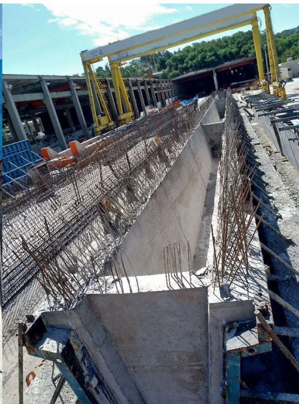
Figura 9 - (a) Armação das vigas (b) Viga já concretada na forma.
