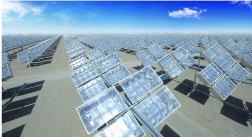
Figura 7 – Sistema HCPV de 140 MW instalado pela Suncore em Golmud-China.
