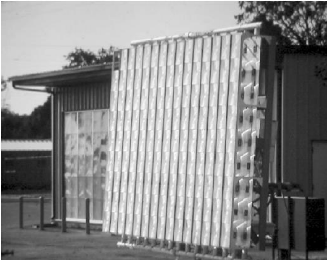
Figura 1 – O sistema fotovoltaico com concentração Sandia II. O primeiro sistema CPV moderno feito nos laboratórios Sandia nos EUA em 1977.
