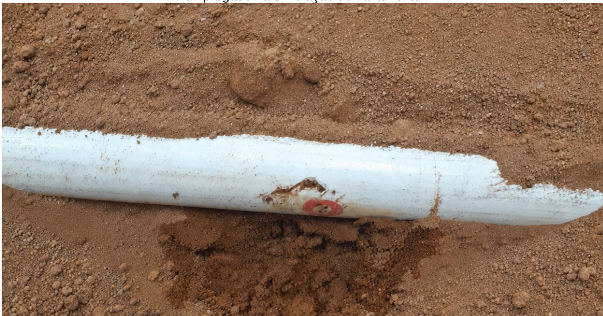
Figura 9: Tubulação de PVC utilizada na bancada experimental, no cenário 2, com o orifício lateral empregado na simulação do vazamento.
