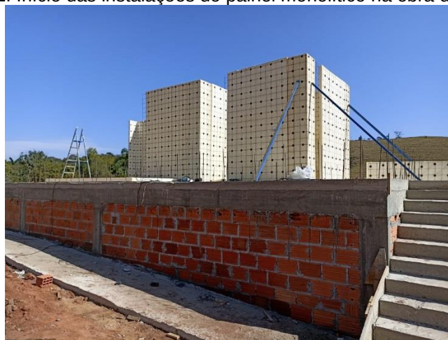
Figura 22: Início das instalações do painel monolítico na obra de estudo de caso.
