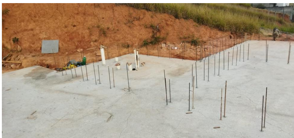
Figura 7: Instalação das armaduras de arranques.
