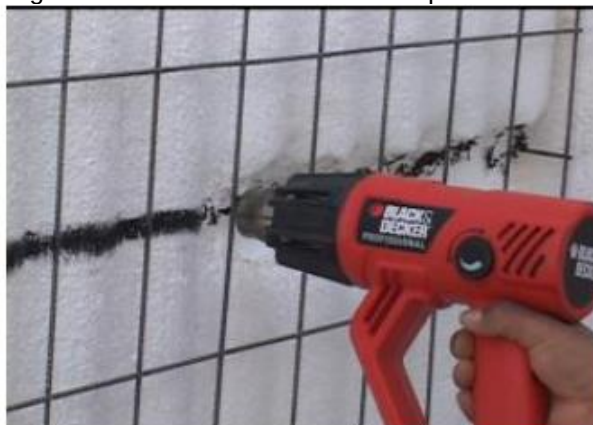
Figura 16: Abertura do EPS com soprador térmico
