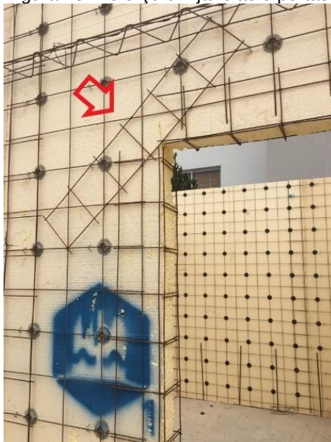
Figura 13: Reforço em janelas e portas.
