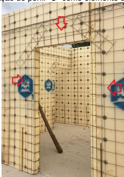
Figura 12: Instalação do perfil "U" como elemento de reforço de vãos.
