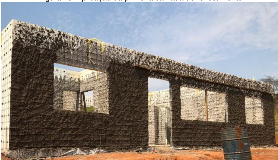
Figura 18: Aplicação da primeira camada de revestimento.
