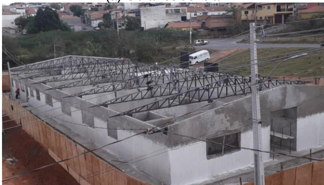
(b) Obra comercial.
