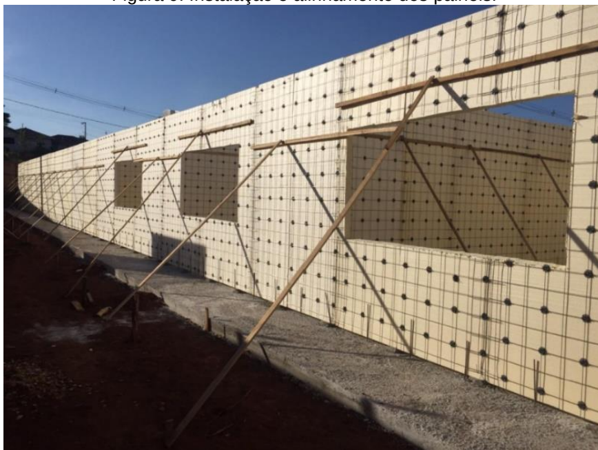
Figura 9: Instalação e alinhamento dos painéis.
