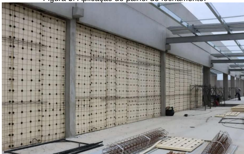
Figura 5: Aplicação do painel de fechamento.
