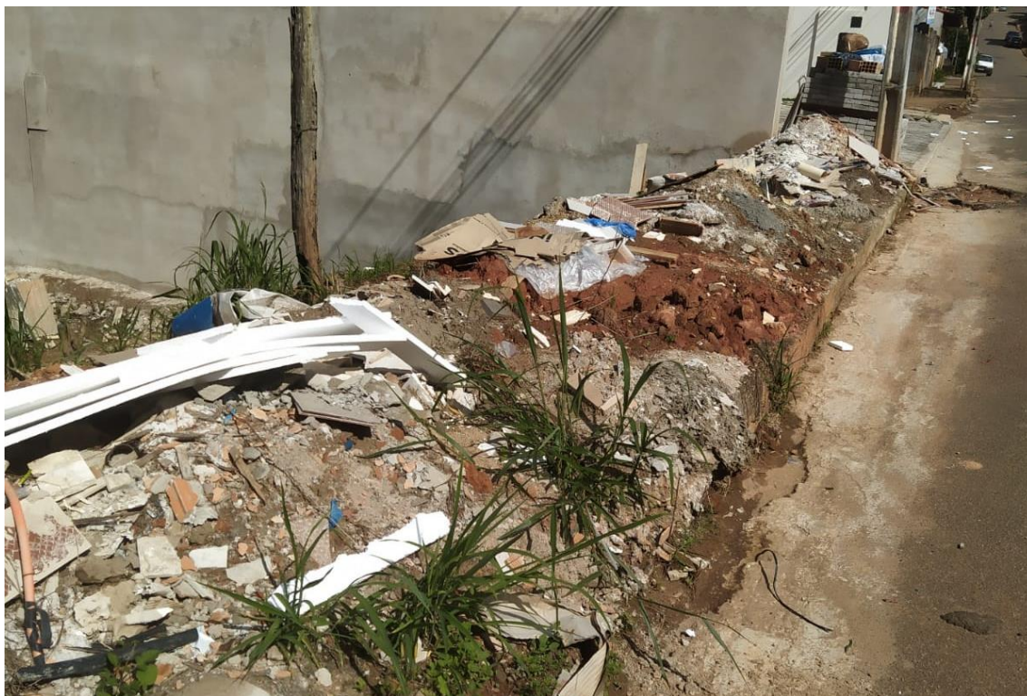
Figura 8: Resíduos de Construção Civil no Bairro Vista da Serra.
