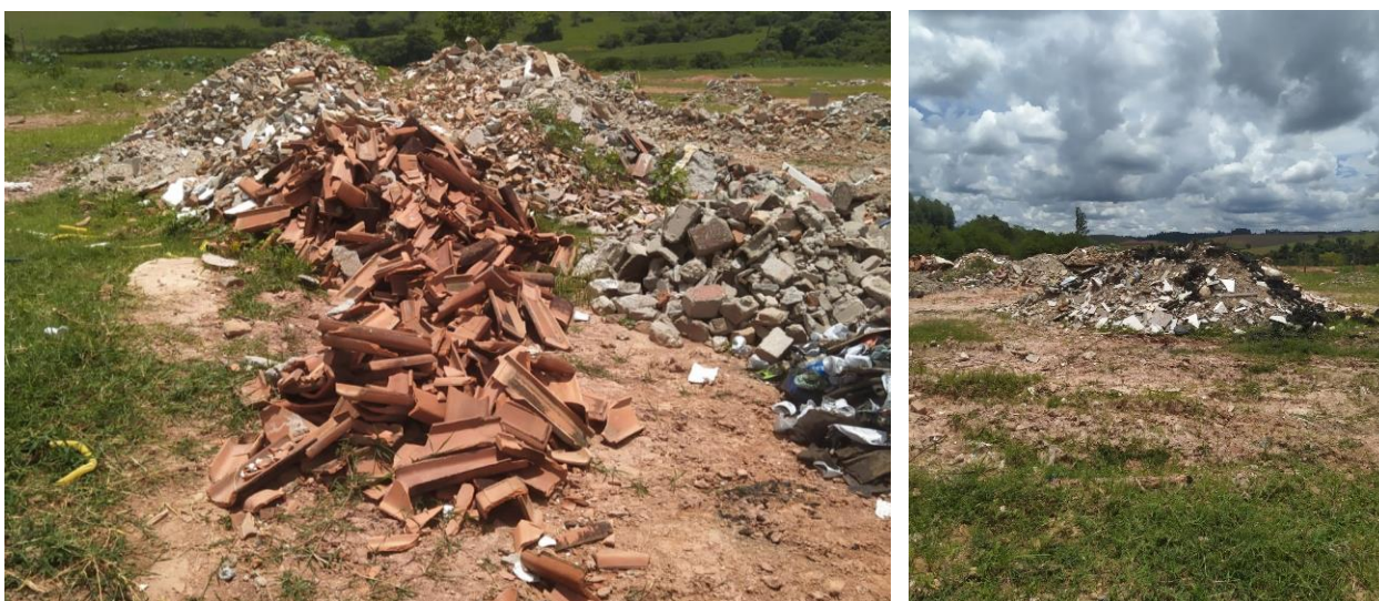
Figura 23: Resíduos de Construção Civil no Lixão.
