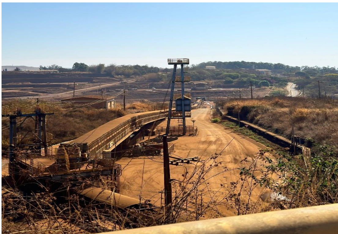
Figura 20: Correia transportadora da empresa CBMM vista da rodovia MG-428
