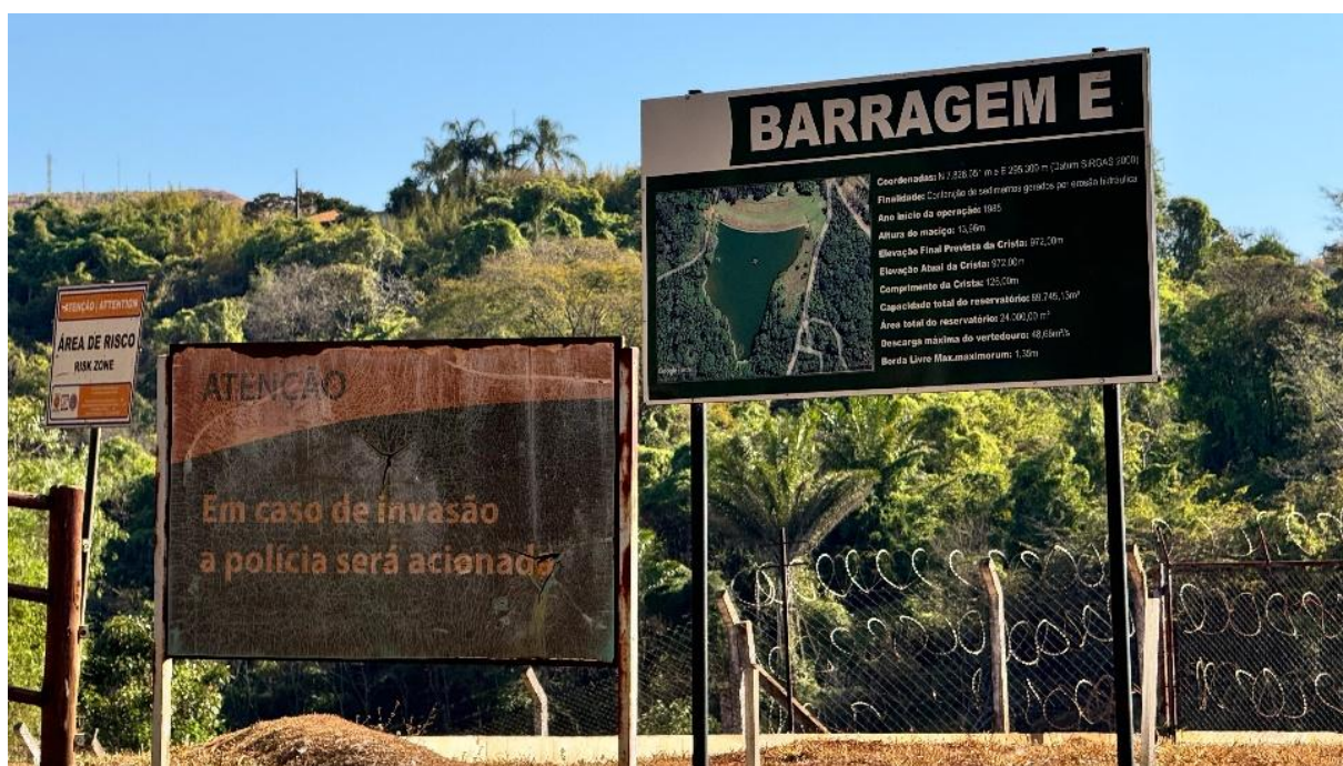
Figura 15: Placa da Barragem E da empresa Mosaic
