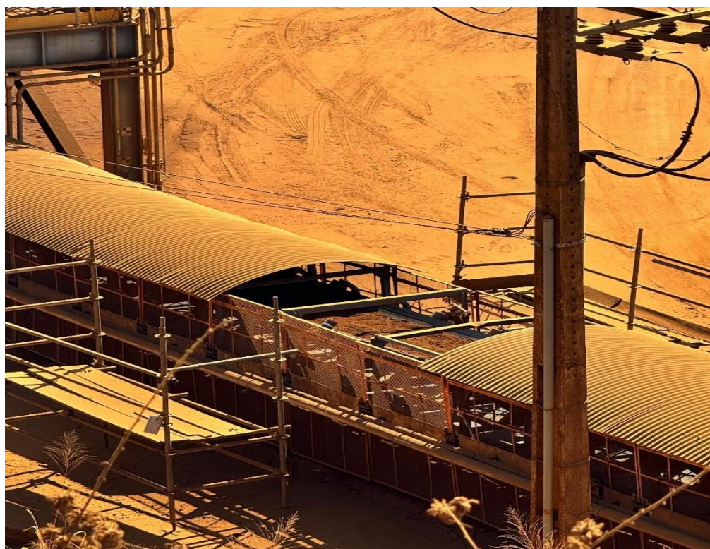
Figura 21: Correia transportadora da empresa CBMM vista da rodovia MG-428
