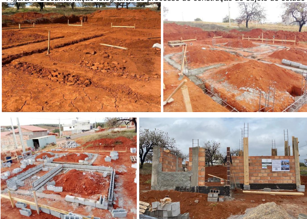
Figura 7: Documentação fotográfica do processo de construção do objeto de estudo
