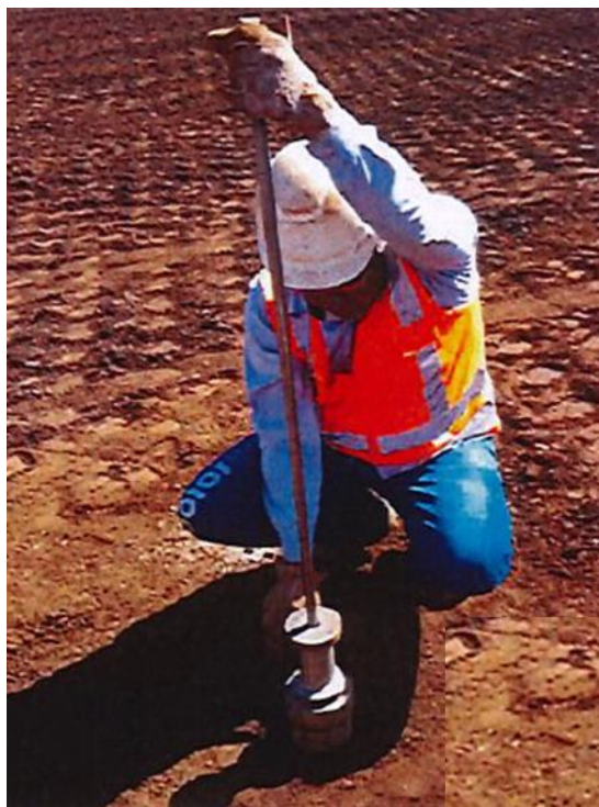
Figura B13 – Etapa operacioonal – controle tecnológico
