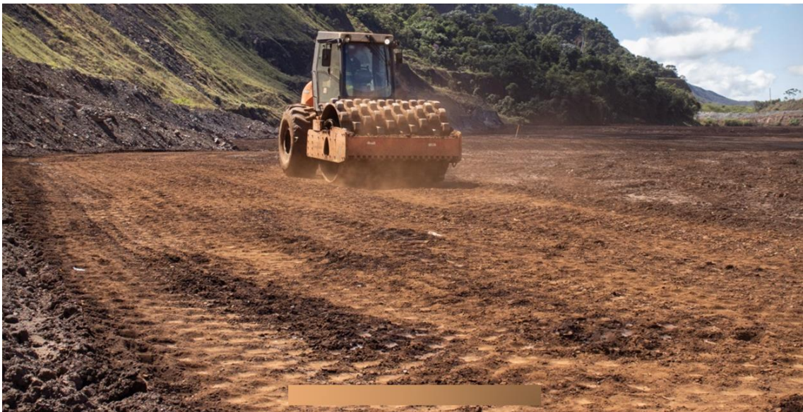
Figura B12 – Etapa operacional – compactação de material
