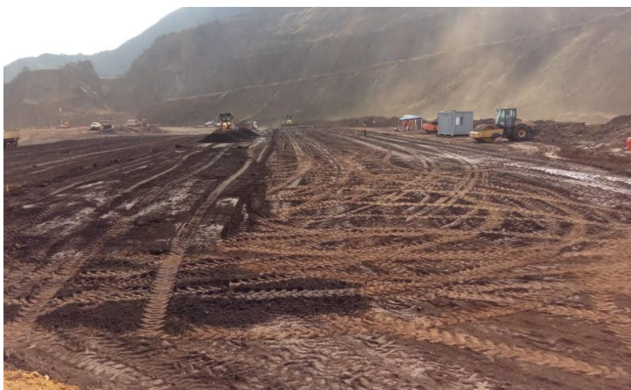
Figura B2 – Espalhamento do material – primeira diretriz operacional
