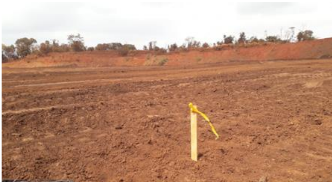
Figura B3 – Marcação topográfica – primeira diretriz operacional
