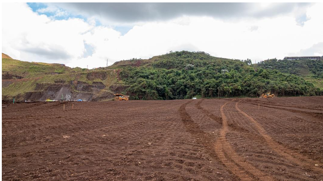
Figura B6 – Compactação – Segunda diretriz operacional
