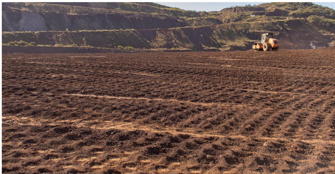
Figura B9 – Compactação – Segunda diretriz operacional
