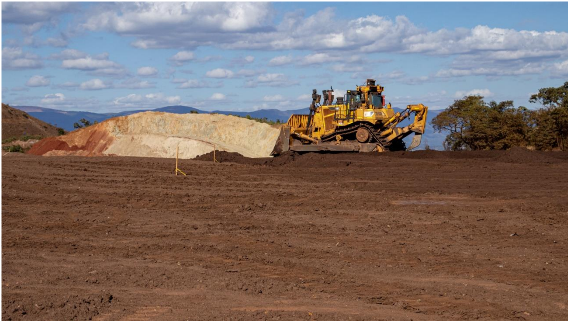
Figura B11 – Etapa operacional – espalhamento de material
