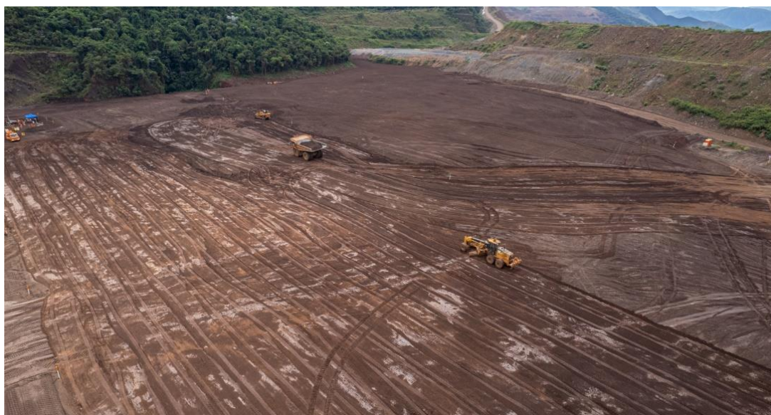
Figura B7 – Nivelamento – Segunda diretriz operacional
