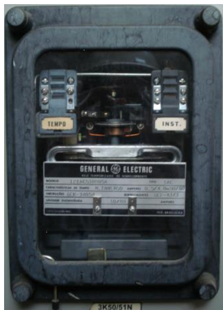
Figura 2.1 - Relé eletromecânico. Fonte: SILVEIRA, 2017.
