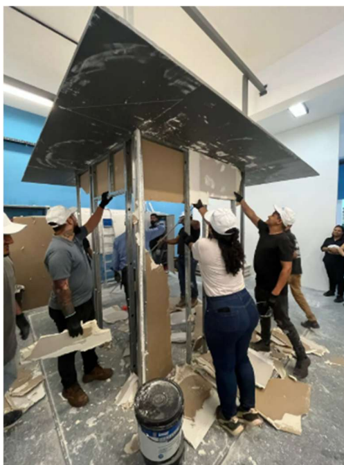
Figura 1 - Capacitação em Técnicas de Montagem de drywall
