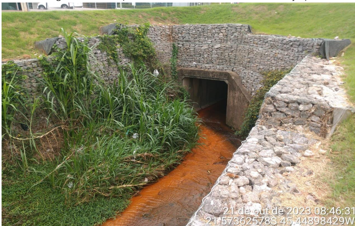
Figura 30: Bueiro (travessia ao fim do Trecho III da canalização).
