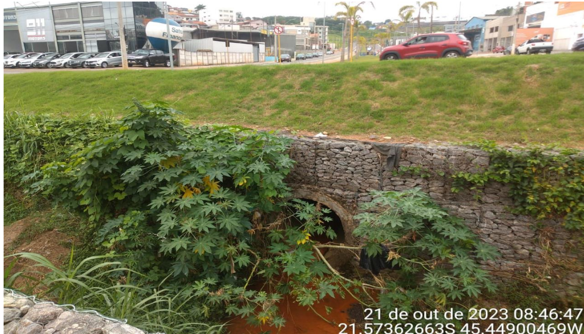
Figura 38: Chegada da manilha de 1500 mm da canalização de curso d'água.
