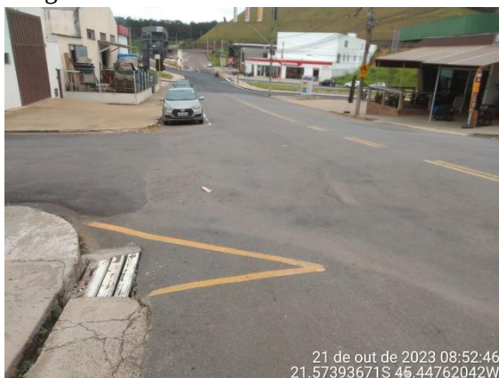
Figura 43: Bueiro na Avenida Santa Luiza.
