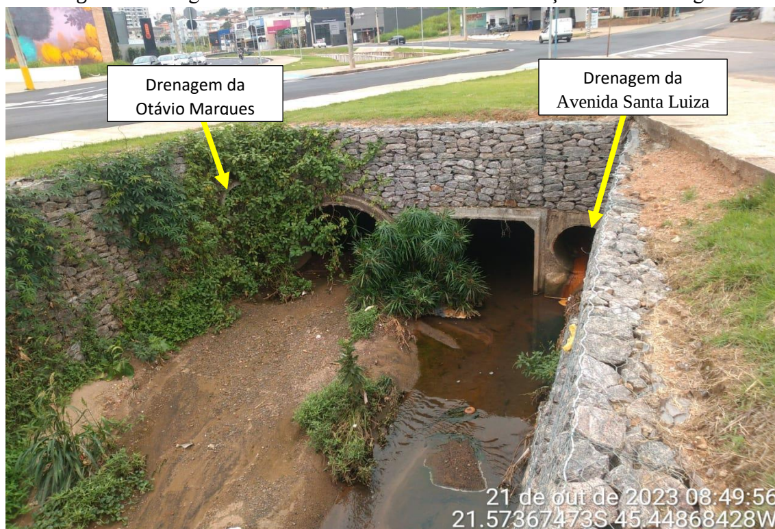
Figura 39: Chegada da manilha de 1500 mm da canalização de curso d'água.
