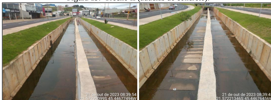
Figura 19: Trecho II (aduelas de concreto).
