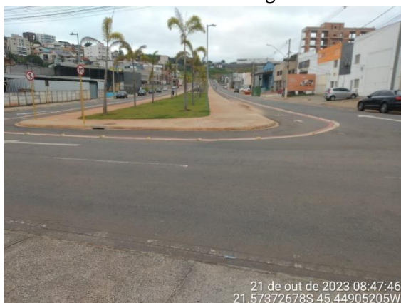
Figura 42: Bueiro na Otavio Marques com Alameda Olívio Bregalda
