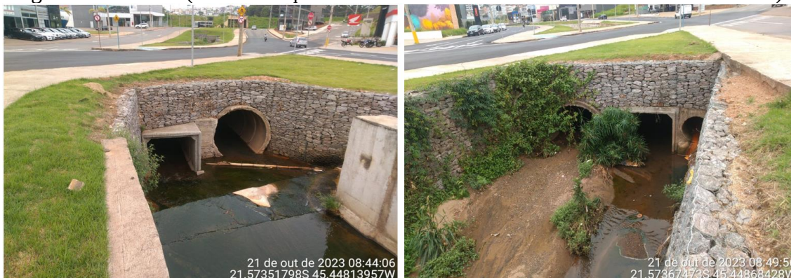
Figura 32: Bueiros (Fotos: à esquerda - final do Trecho II e à direita – início do Trecho III).
