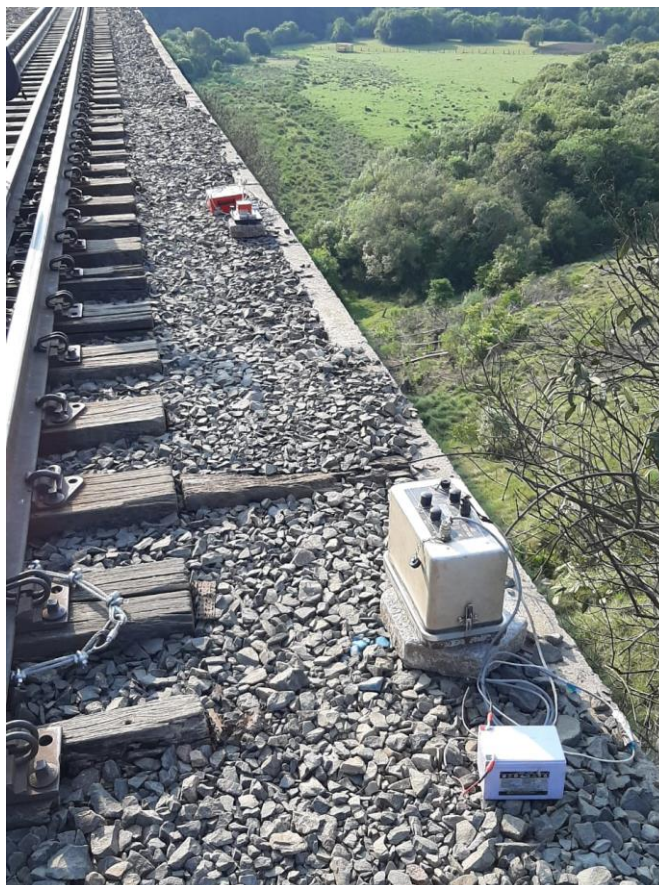
Figura 24 – Sismógrafos posicionados no tabuleiro.
