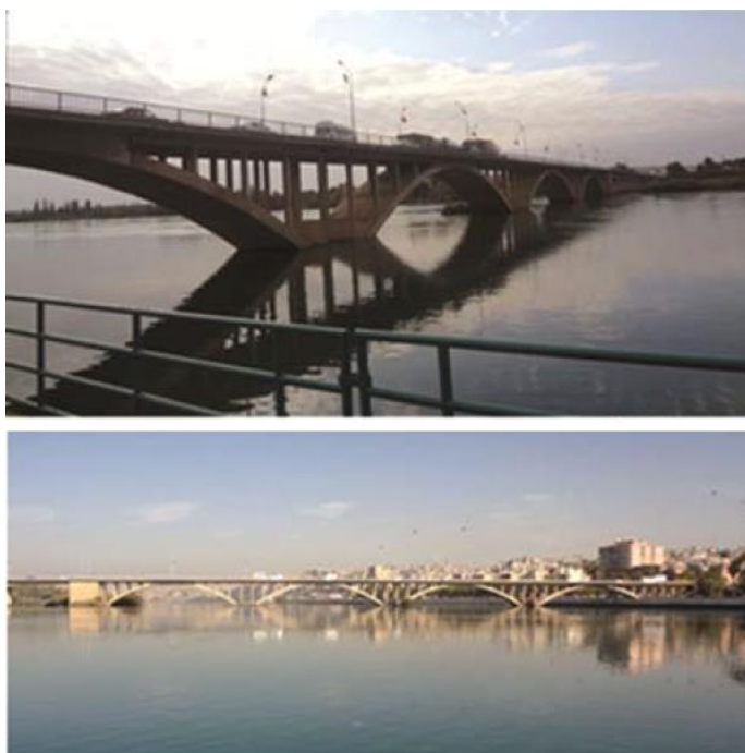
Figura 3 – Ponte em arco sob o tabuleiro.
