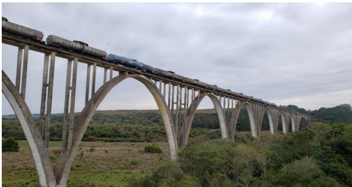
Figura 10 – Ponte dos Arcos
