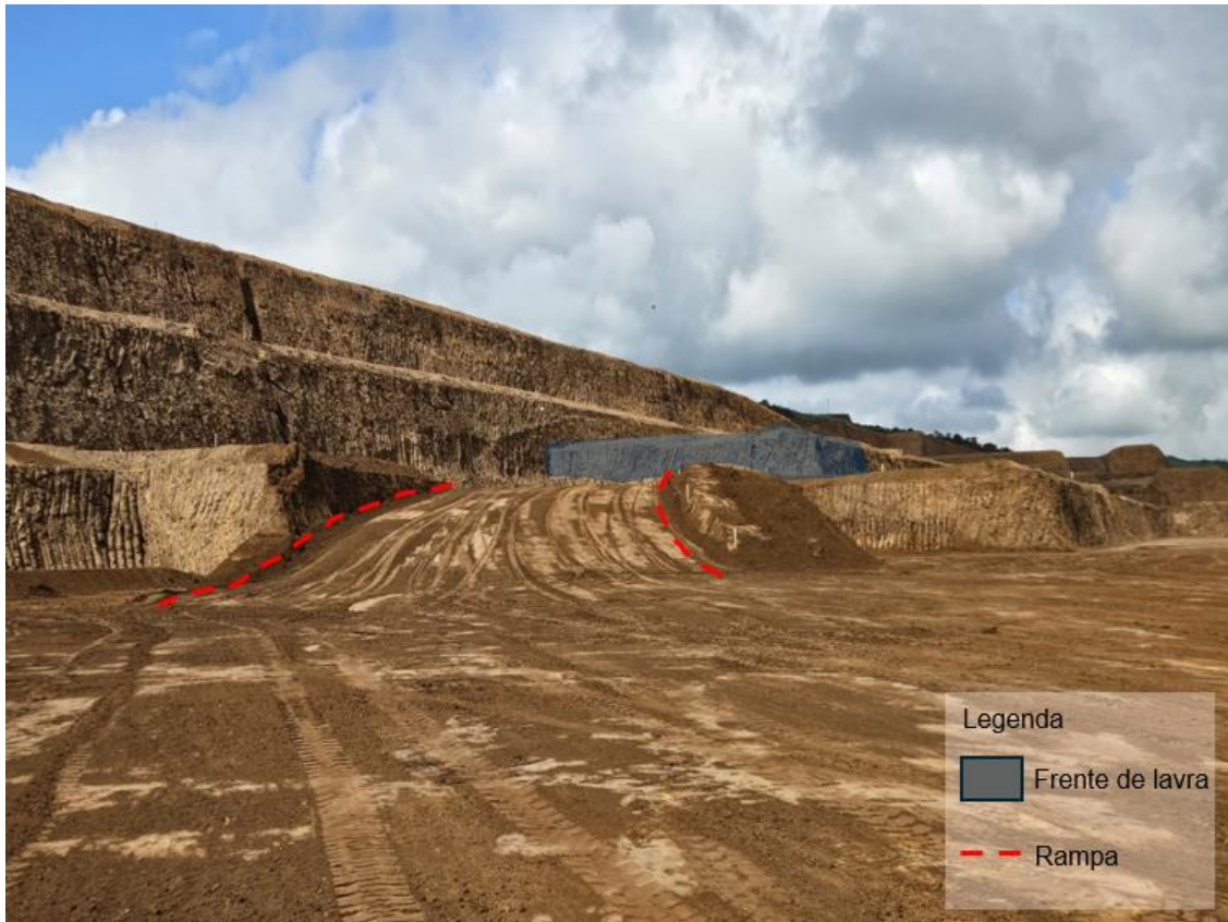
Figura 4.27 - Rampa de acesso construída para redução de DMT
