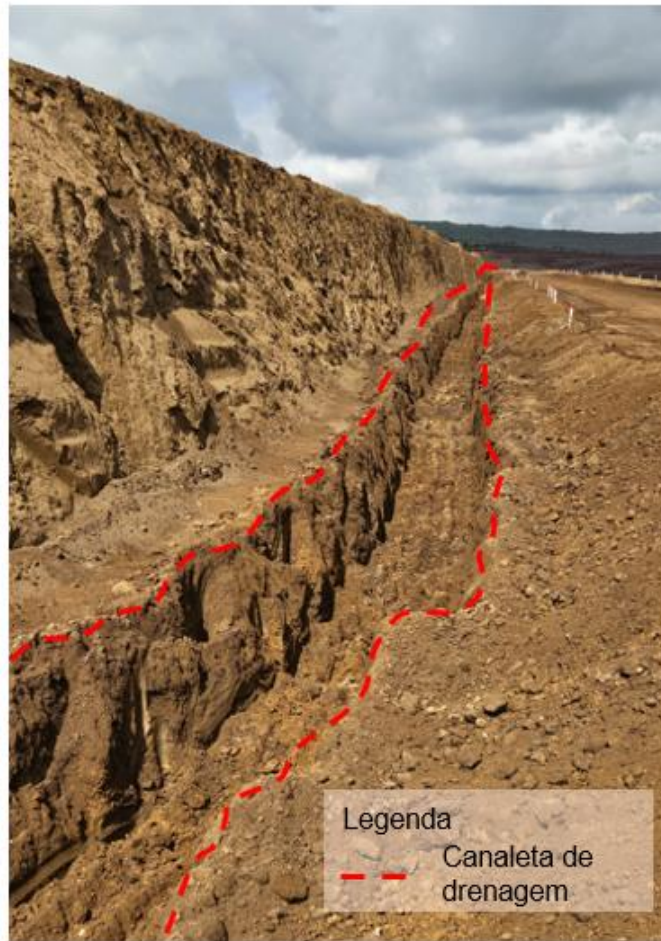
Figura 4.28 - Canaleta de drenagem
