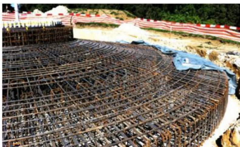
Figura 3.3 Fundação circular de uma turbina eólica [20].
