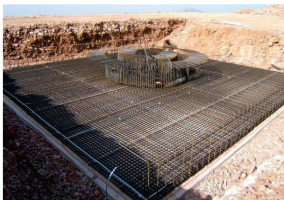
Figura 3.2 Fundação retangular de uma turbina eólica [19].
