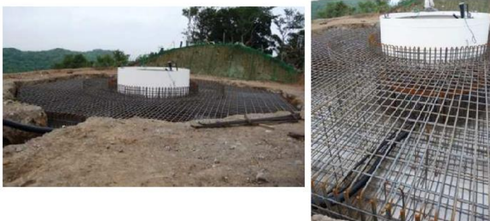
Figura 3.1 Fundação octogonal de uma turbina eólica [18].
