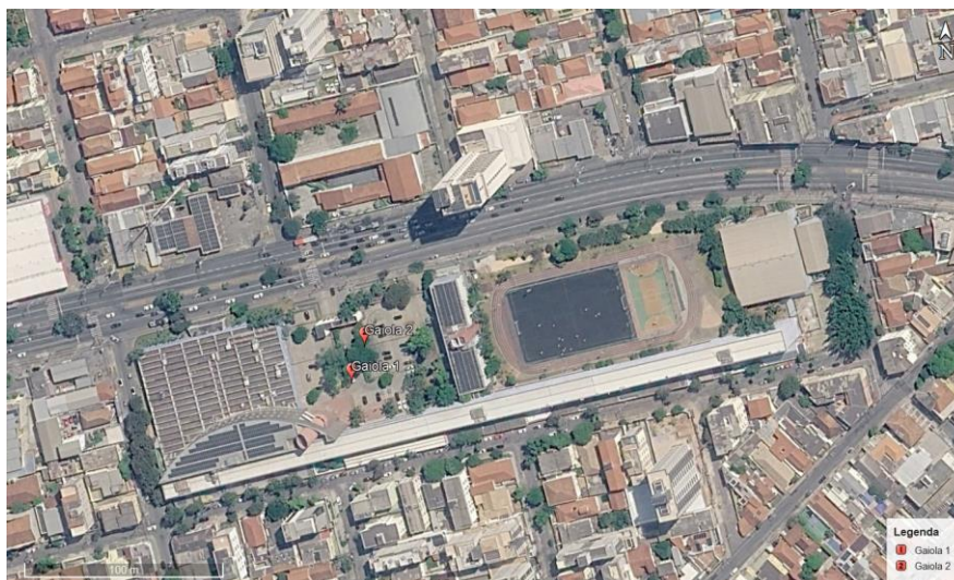
Figura 19- Mapa de localização e disposição espacial dos bueiros monitorados no parque de estacionamento do Campus Nova Suíça
