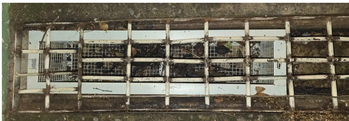
Figura 33- Grelha superior do bueiro (Gaiola 2),
