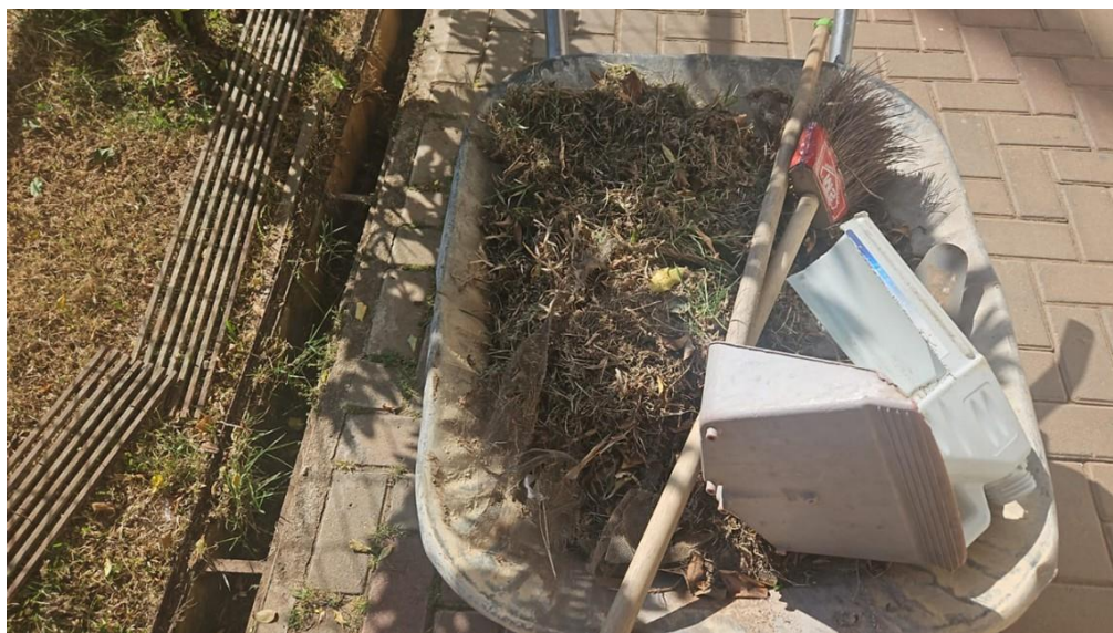
Figura 2-Material coletado dos bueiros pluviais CEFET-MG
