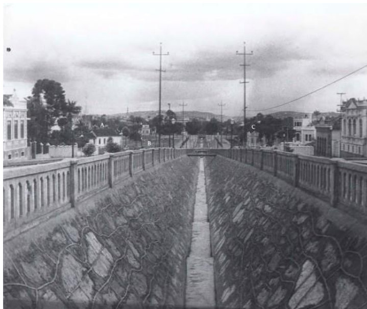
Figura 7- Canal do Córrego do Acaba Mundo, Avenida Afonso Pena, 1929
