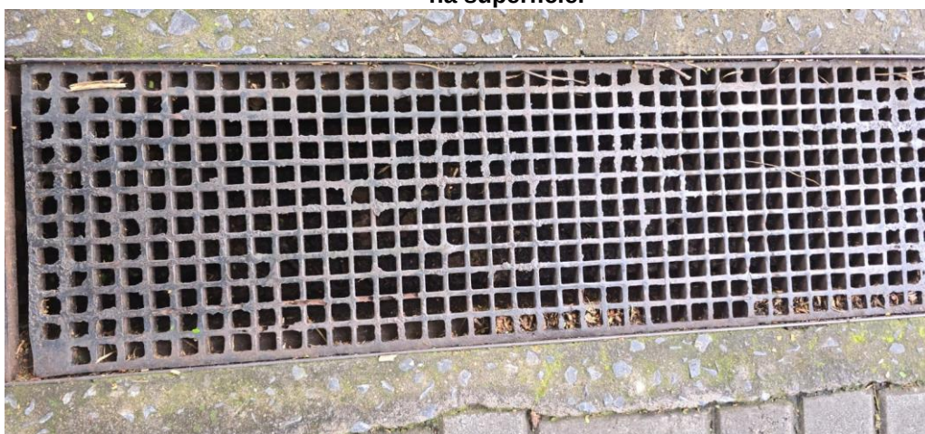
Figura 25- Grelha superior da galeria pluvial (Gaiola 1), responsável pela retenção primária na superfície.
