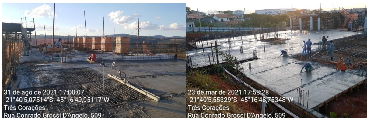
Figura 41 – Acabamento das lajes
