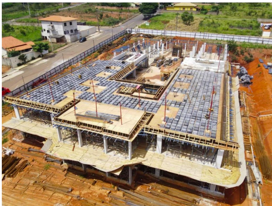
Figura 21 – Montagem das fôrmas das vigas e lajes nervurada e maciça
