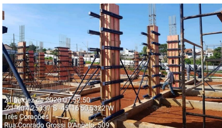
Figura 14 – Fôrmas dos pilares do subsolo
