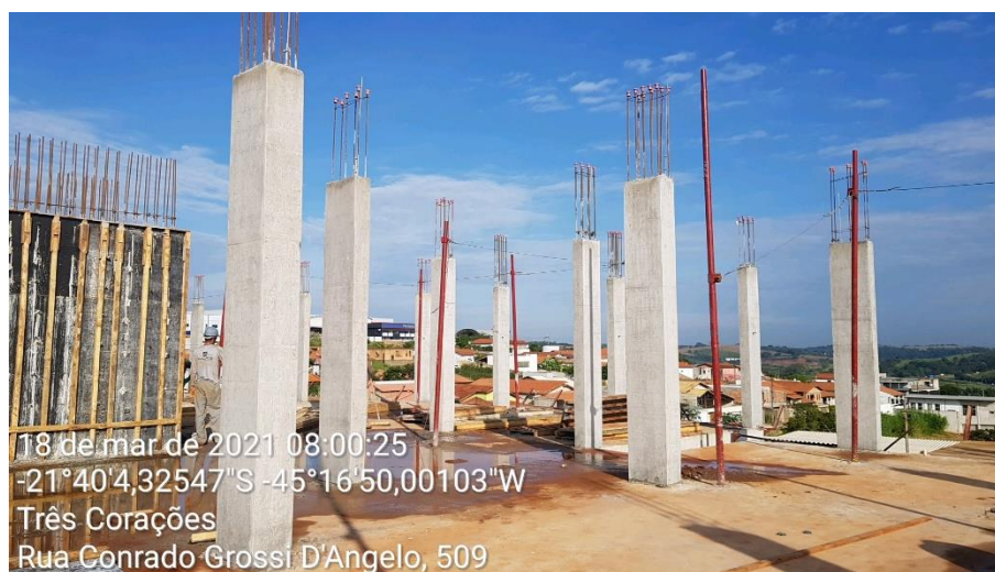
Figura 53 – Desfôrma dos pilares
