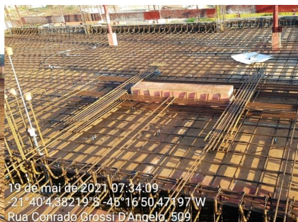
Figura 23 – Armação das lajes maciças
