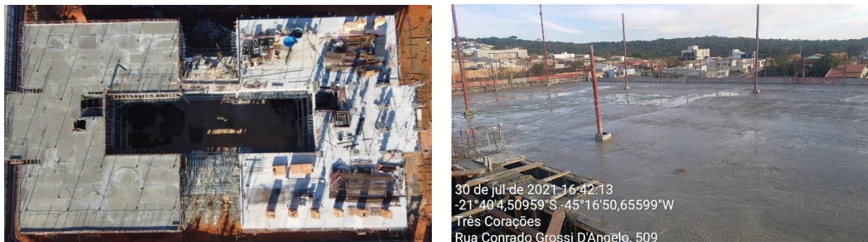
Figura 59 – Acabamento das lajes
