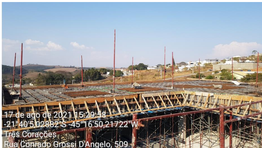
Figura 20 – Travamento lateral de vigas
