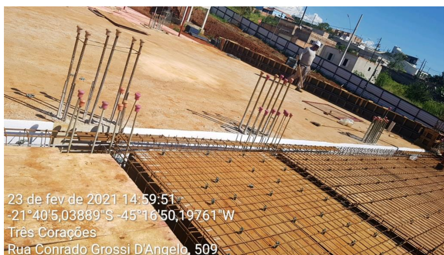
Figura 25 – Placas de isopor posicionadas na região da junta de dilatação
