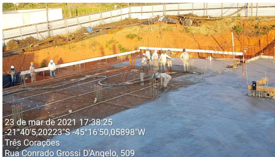
Figura 49 – Paralisação da concretagem das lajes
