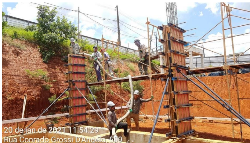
Figura 36 – Concretagem dos pilares
