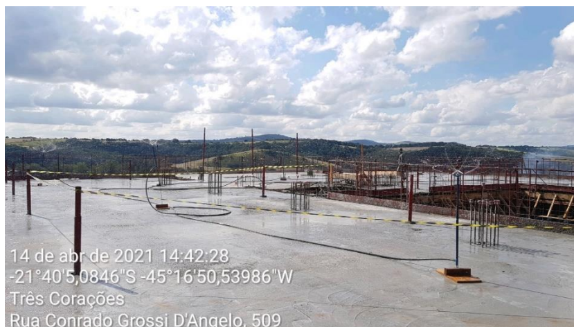
Figura 43 – Cura úmida com aspersores
