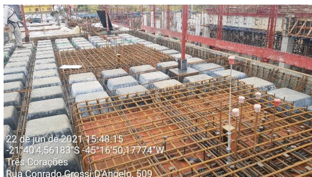
Figura 24 – Armação das lajes nervuradas
