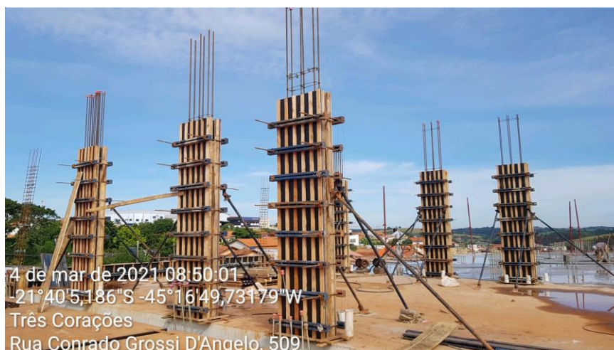
Figura 15 - Fôrmas dos pilares do 1º pavimento
