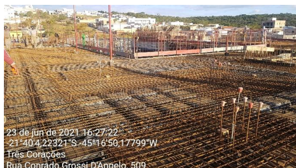
Figura 24 – Armação das lajes nervuradas
