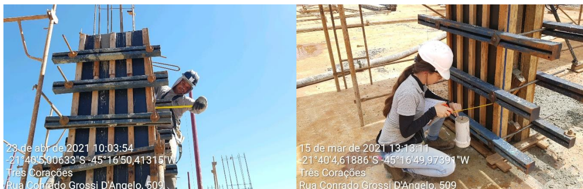
Figura 39 – Verificação do prumo dos pilares
