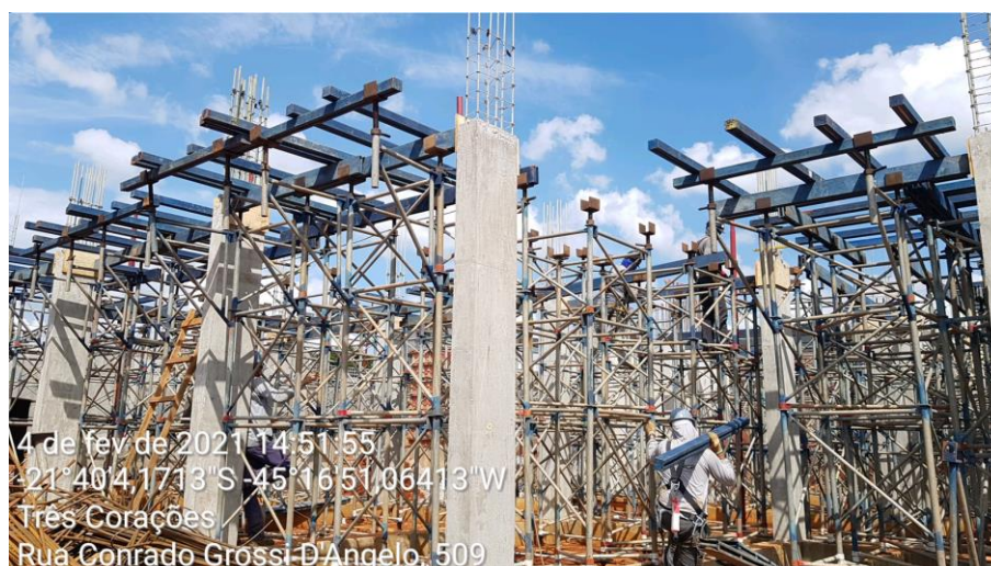
Figura 18 - Montagem do cimbramento para lajes e vigas
