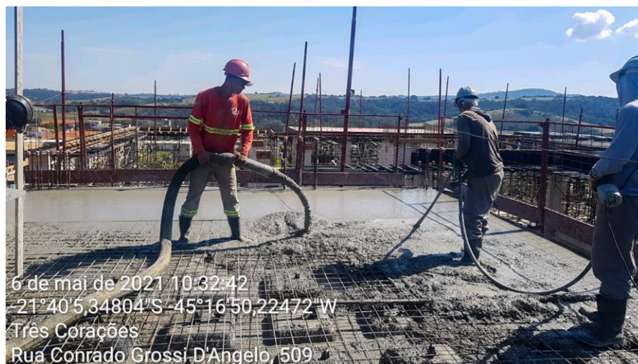
Figura 38 – Lançamento e adensamento do concreto
