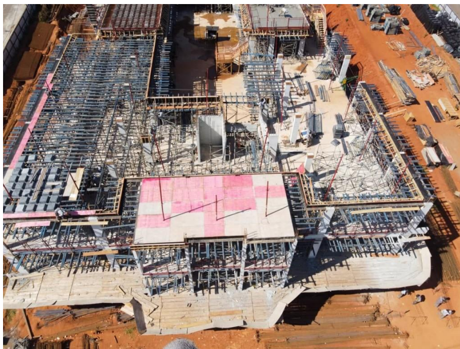
Figura 17 – Montagem do cimbramento para lajes e vigas
