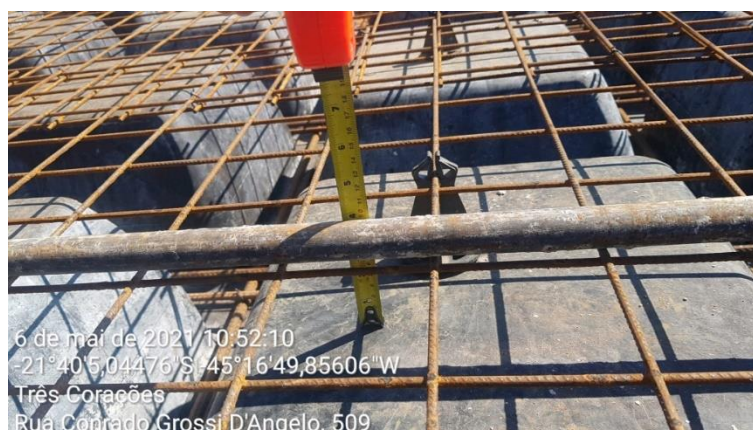
Figura 40 – Conferência do posicionamento das mestras metálicas
