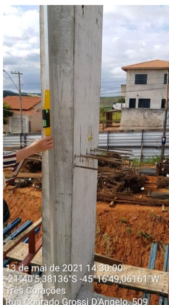
Figura 46 – Conferência do prumo dos pilares
