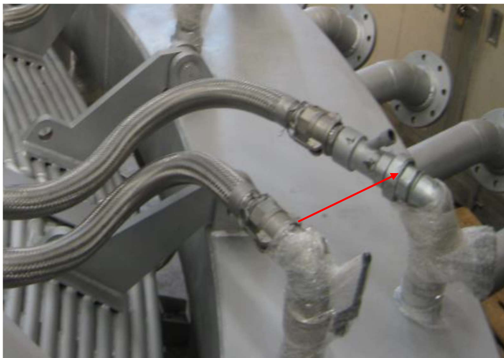
Figura 26 - Montagem de um painel refrigerado Fonte: Próprio autor
