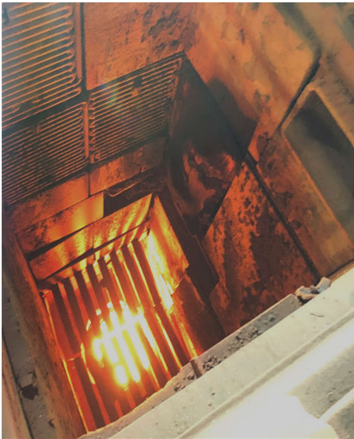
Figura 21 - Painéis no interior do forno EOF Fonte – Próprio autor
