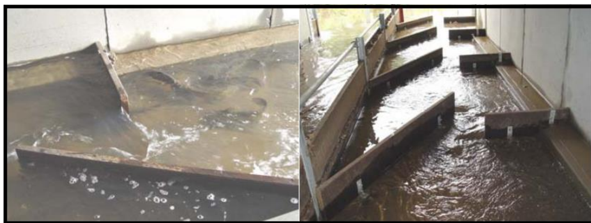
Figura 26 - Descanso dos peixes atrás do defletor perpendicular e visão geral com fluxo raso.
