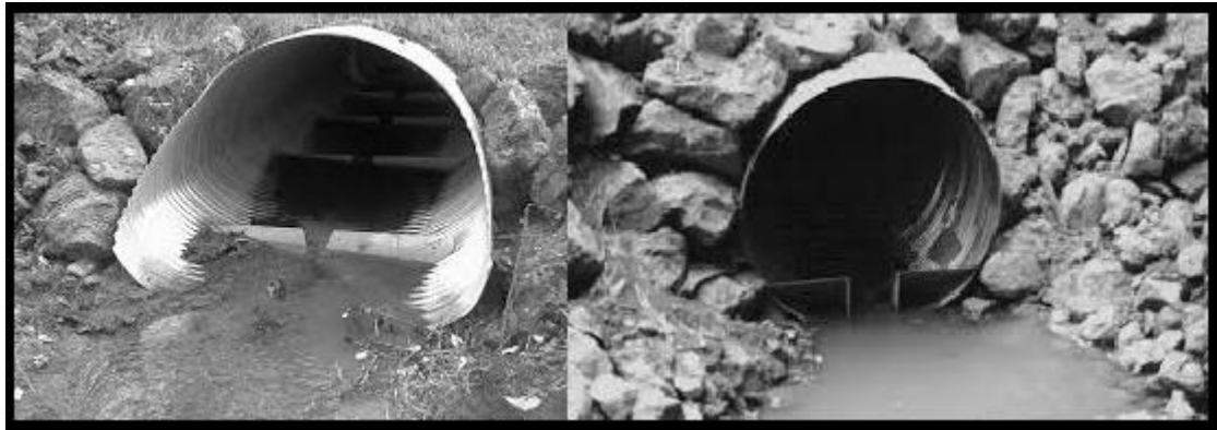
Figura 28 - Exemplos de bueiros com defletores slotted weir .
