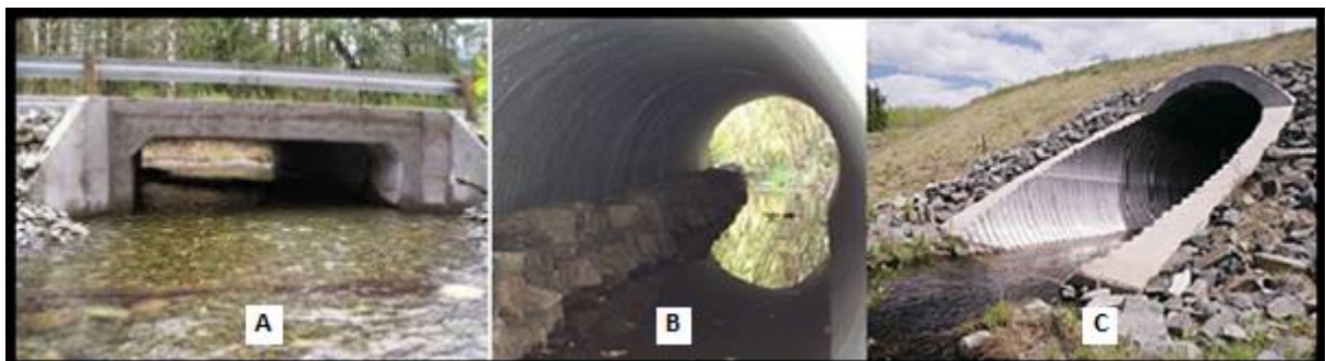
Figura 6 – Bueiros: (a) sumidouro de água; (b) corrugado com passagem seca formada por pedras na lateral; (c) armco com borda em concreto na entrada e entorno em pedras, para melhor visualizacão.
