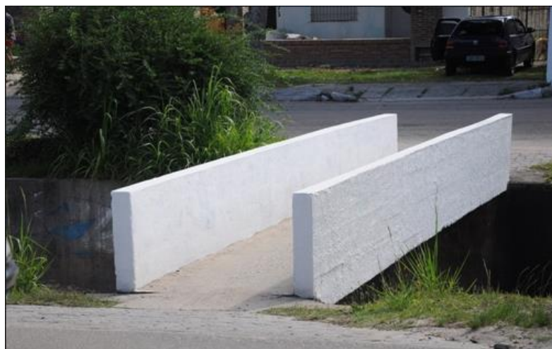
Figura 8 - Exemplo de pontilhão específico para trânsito de pedestres.
