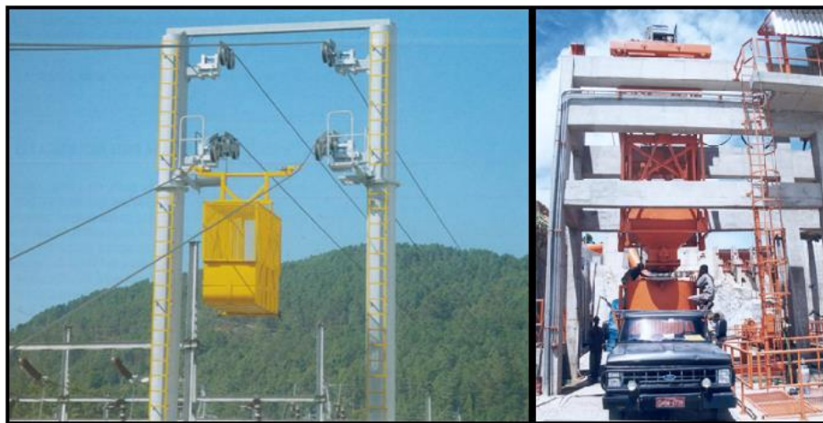
Figura 17 – (a) Elevador para peixes tipo teleférico e (b) caminhão tanque.
