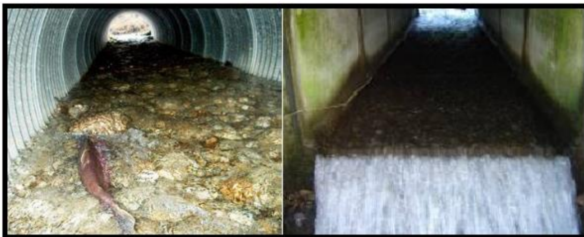
Figura 23—Contraste: passagem de peixe pelo Ecobueiro e bueiro intransponível.
