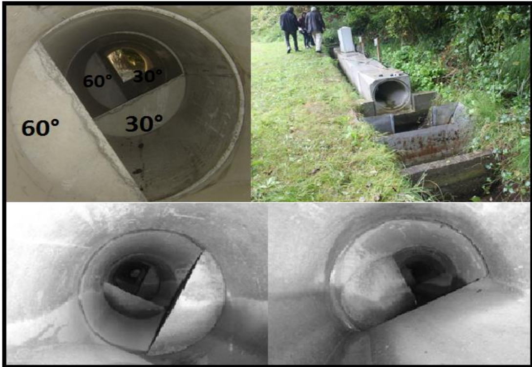
Figura 32 - Visão dos pontos de conforto para peixes no bueiro Stair Pipe .
