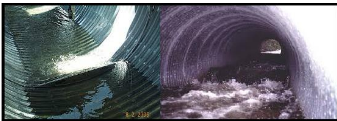
Figura 30 - Exemplos de bueiros com defletores weir.
