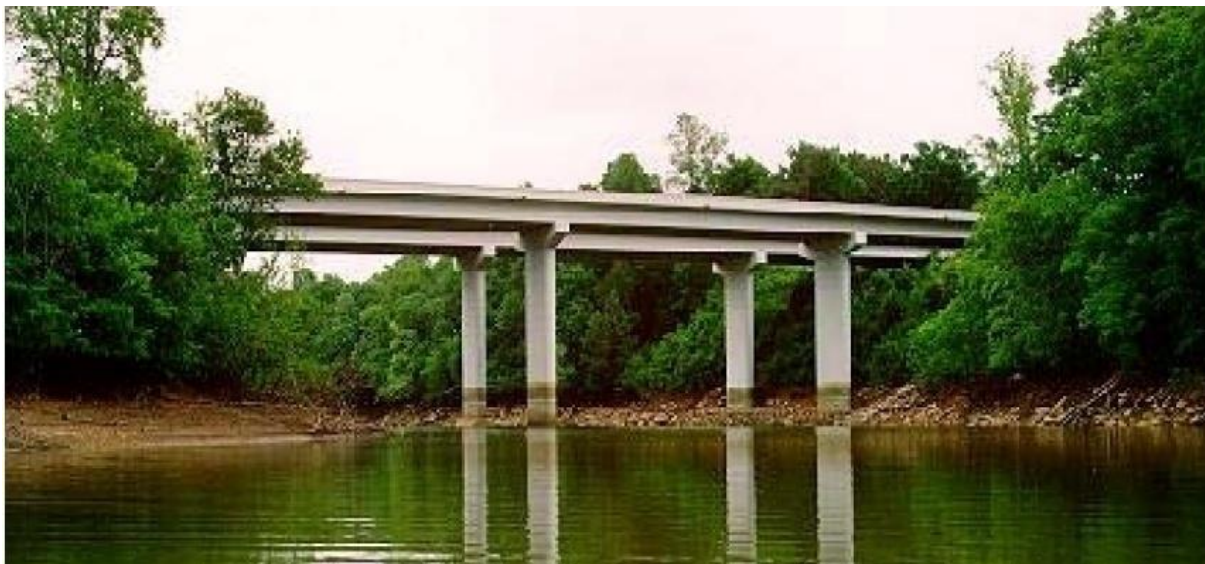
Figura 7 - Ponte para transposição em cursos d'água de grande porte.
