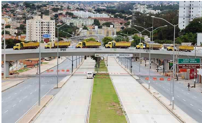
Figura 11: Prova de carga estática do viaduto Montese (Fonte: site do Jornal Estado de Minas)
