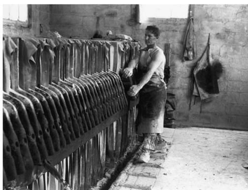
Figura 1 – Filtro prensa em operação, no início do século 20 (Museu de Wheal Martyn, St Austell, UK)
