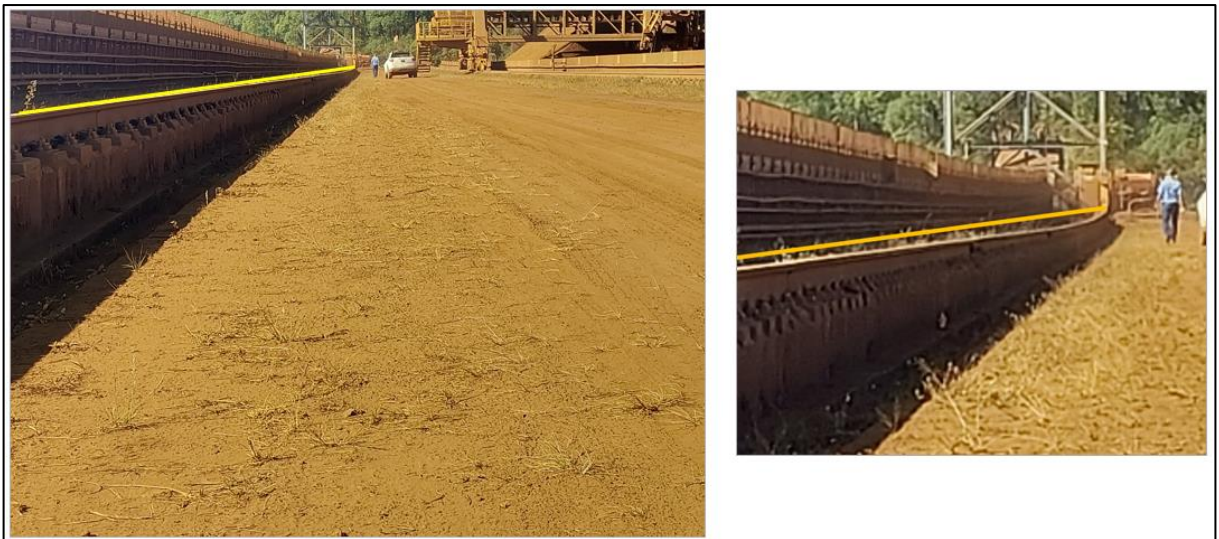
Figura 2-9: Evidência do desnível dos trilhos da Empilhadeira (Stacker). Fonte: Autor (2024).
