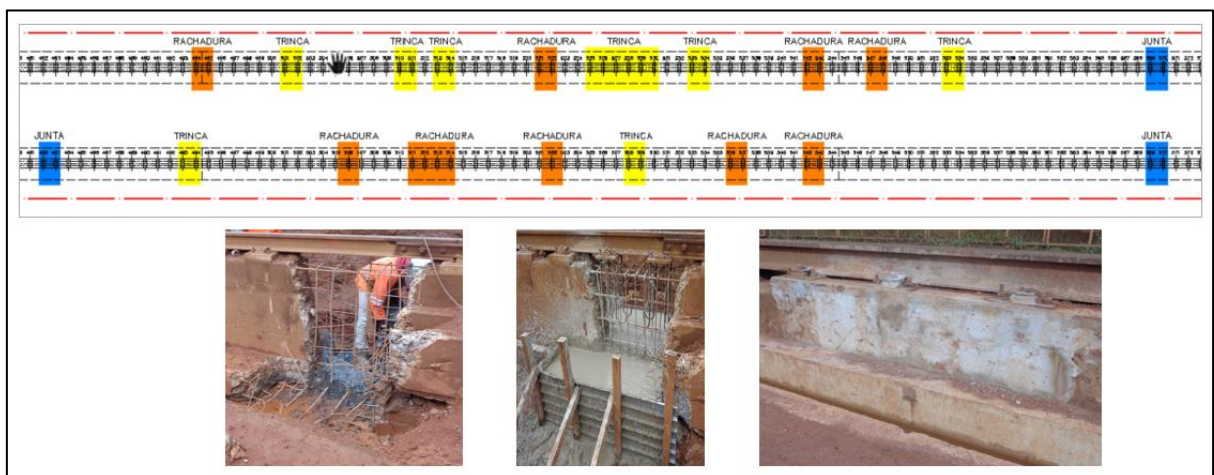
Figura 2-8: Ilustração das correções de trincas e rachaduras da base civil dos trilhos da Empilhadeira (Stacker). Fonte: Autor (2024).
