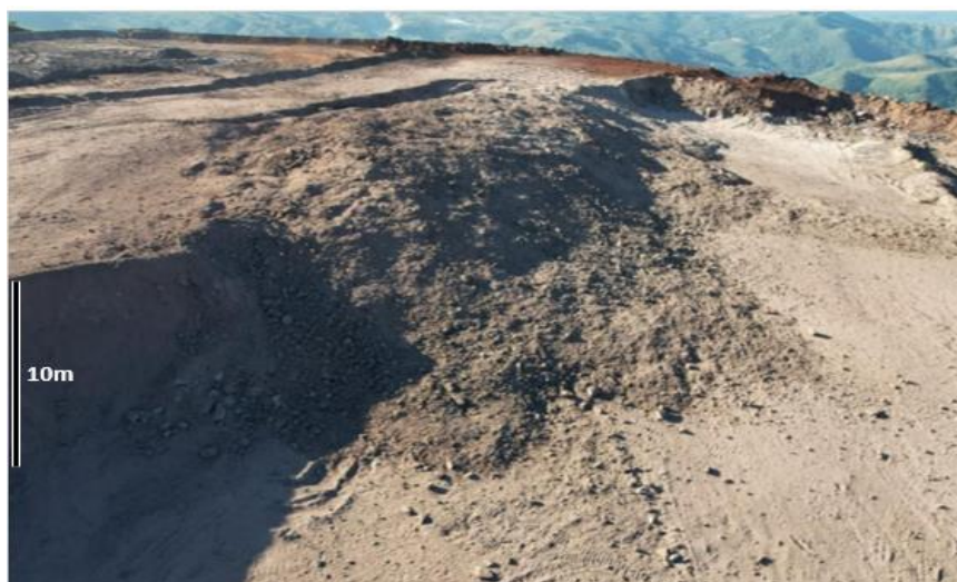
Figura 72 - Execução do desmonte de produção - Bancada 1320 (Q-5)
