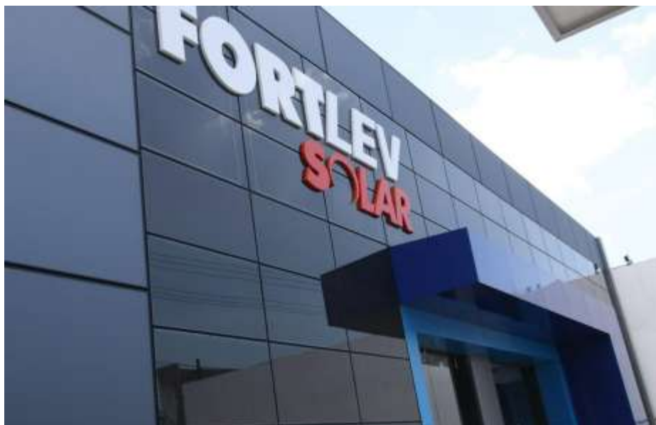
Figura 10: Fachada com utilização de BIPV
