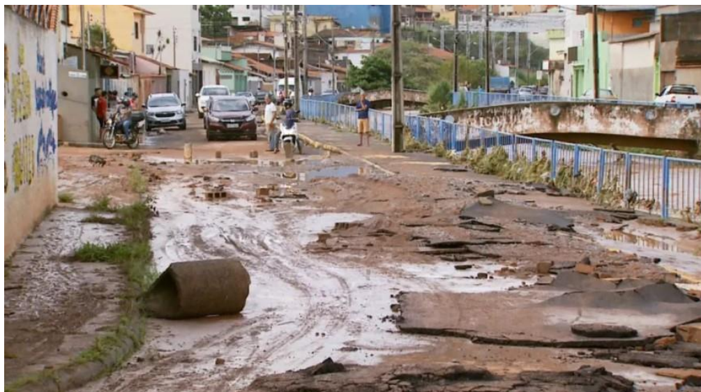
Figura 2 – Prejuízos da Inundação na Av. Zoroastro Franco de Carvalho em fevereiro de 2020.
