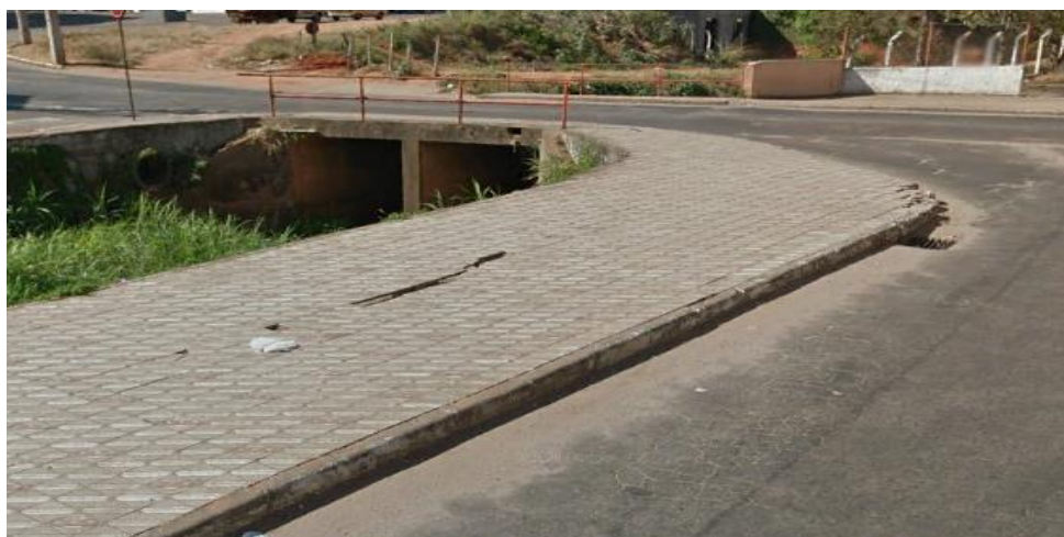
Figura 25 – Ponte sobre a Avenida Imigrantes antes do projeto da rotatória.
