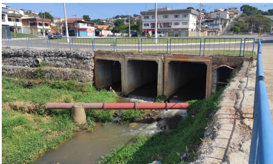
Figura 27 – Saída do exutório da ponte sobre a Avenida Imigrantes.
