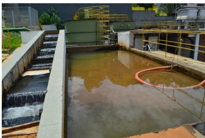
Figura 24 - Chicanas fixas recebendo água bruta com sulfato ferro, decantador
