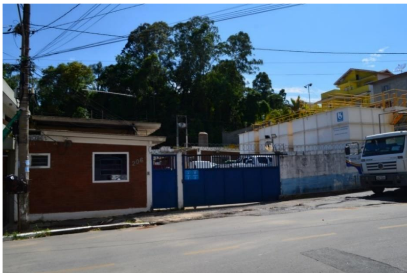
Figura 22 - Portão de acesso para a Estação de Tratamento de Água de Mairiporã
