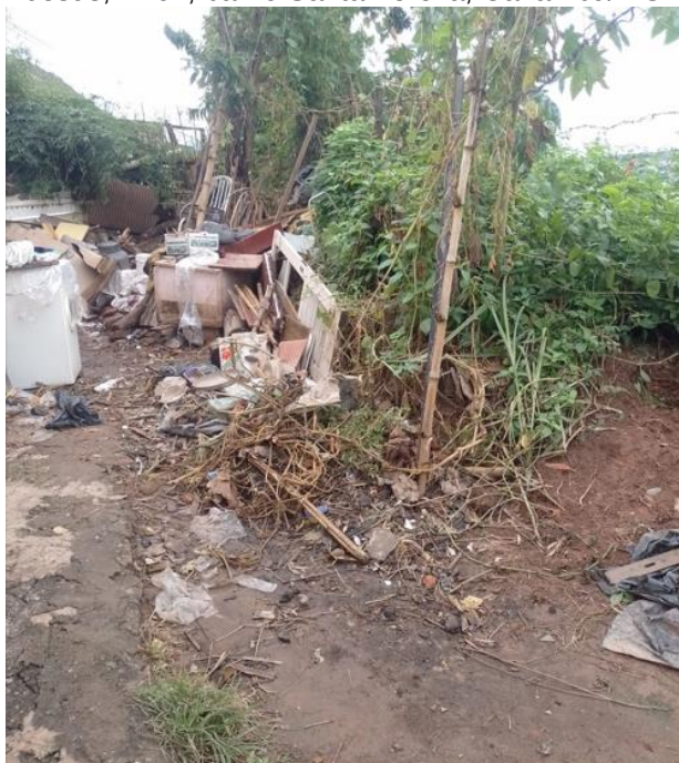
Figura 7: Entulho encontrado na crista do talude da casa situada na Rua Emerenciana Cândida de Jesus, nº 64, bairro Santa Tereza, Caxambu/MG.
