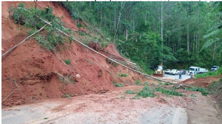
Figura 3: Escorregamento planar após período chuvoso, BR-354, Caxambu-MG.
