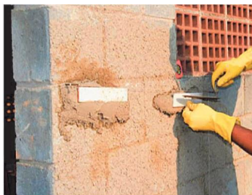
Figura 9 - Instalação das taliscas.
