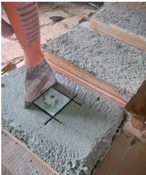
Figura 33 - Execução dos sulcos na argamassa de emboço.
