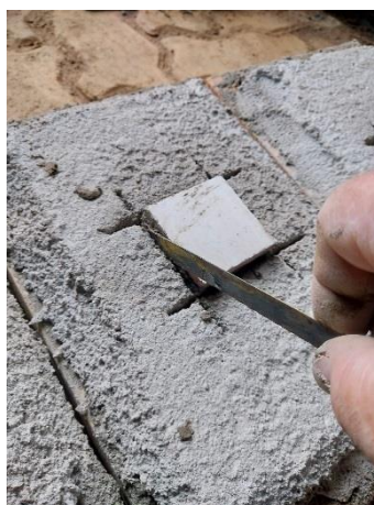
Figura 39 - Limpeza das laterais das placas cerâmicas/remoção dos excessos de AC.
