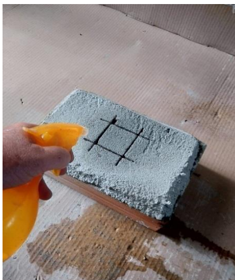
Figura 36 - Hidratação da base para realização do assentamento cerâmico.
