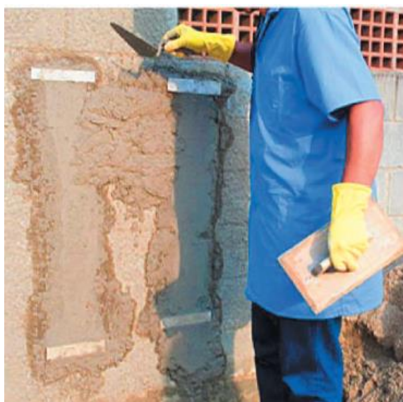
(a) Preenchimento do pano
