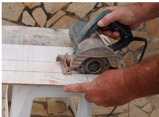
Figura 34 - Corte e preparação das placas cerâmicas 50 mm x 50 mm.
