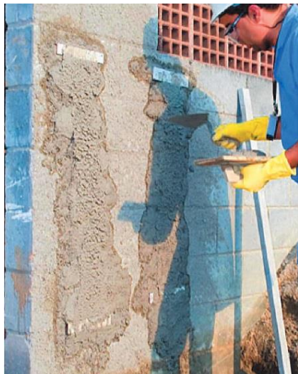
(a) Lançamento da argamassa
