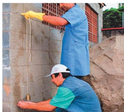
(b) Instalação da linha horizontal inferior
