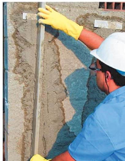
(b) Processo de sarrafeamento
