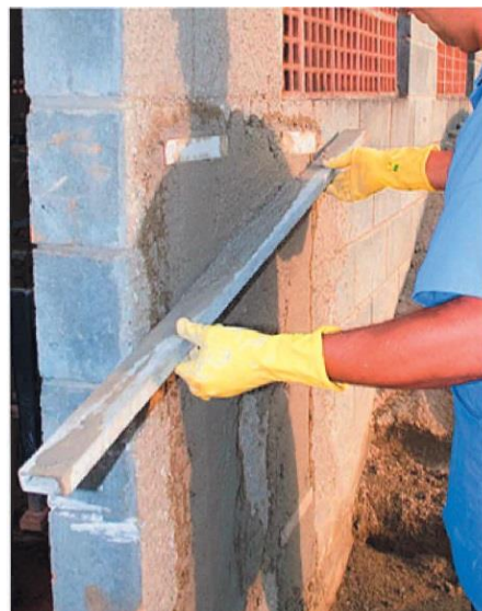
(b) Processo de sarrafeamento
