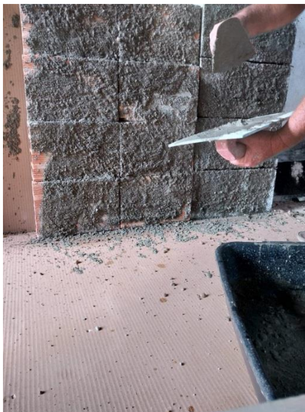
Figura 30 - Aplicação da argamassa de chapisco ao substrato.
