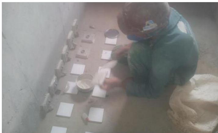
(a) Aplicação dos corpos-de-prova na base com argamassa colante e aderência das placas metálicas de 100 cm 2 sobre os corpos-de-prova.
