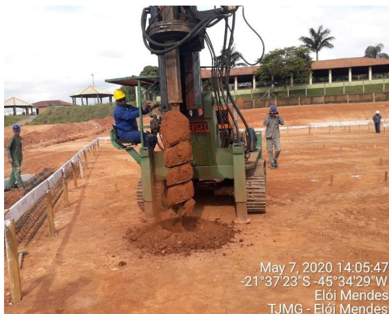
Figura 43: Perfuração das estacas com trado mecanizado.
