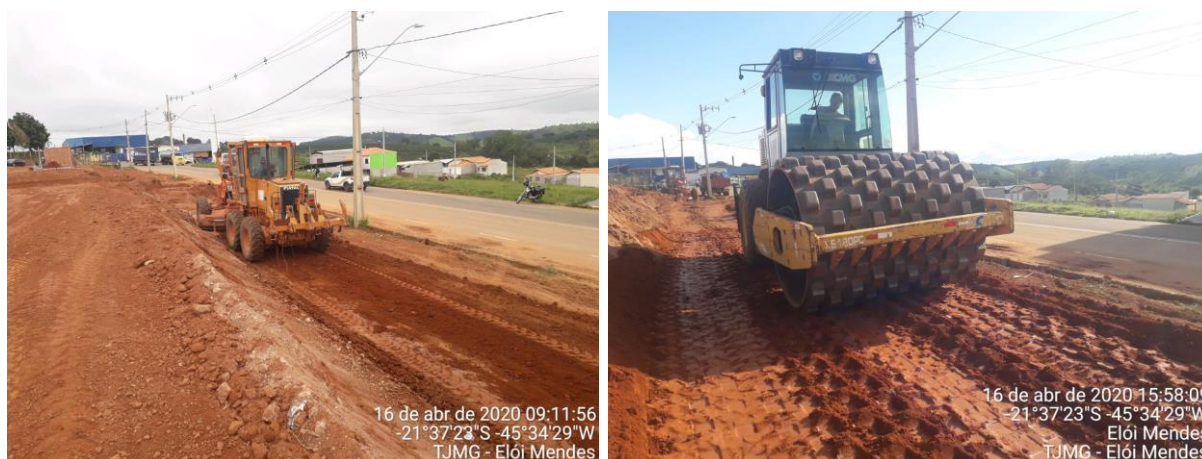
Figura 40: Realização da compactação dos aterros.
