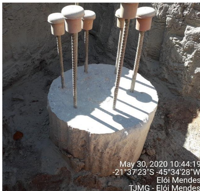
Figura 45: Estaca preparada para execução do ensaio PIT.
