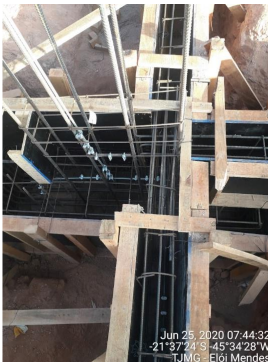
Figura 55: Fôrmas e armaduras posicionadas para execução de viga baldrame.
