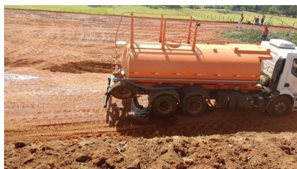
(d) Ajuste de umidade do solo em campo.
