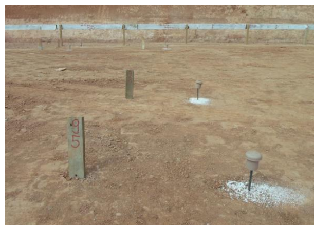
(b) Marcação de estacas após locação.
