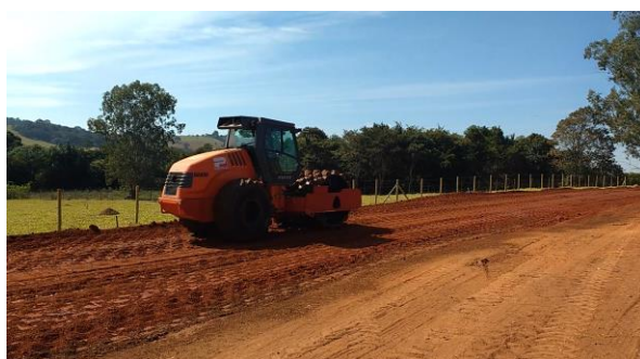
(c) Compactação do aterro pelo pé de carneiro;
