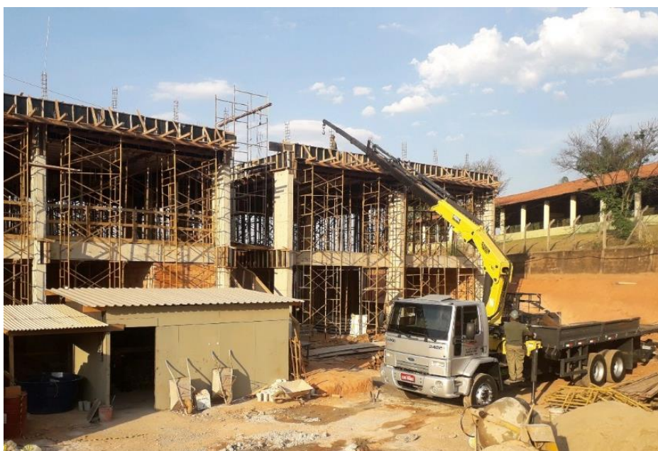
Figura 29: Transporte vertical/horizontal das vigotas protendidas pelo caminhão munk.
