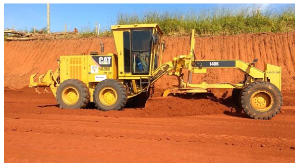
(b) Serviços de espalhamento e regularização de solos por motoniveladora;
