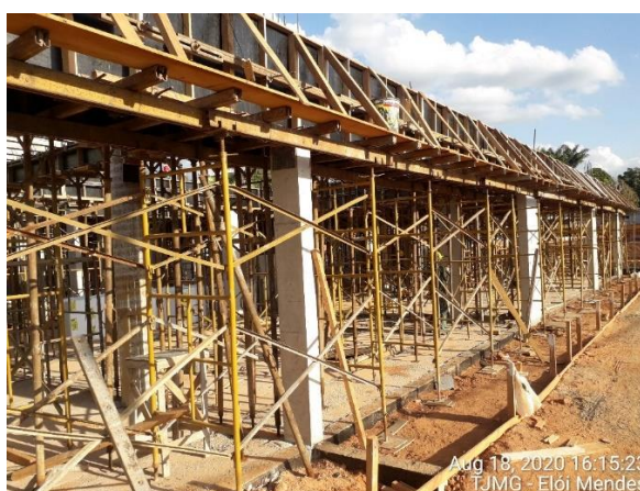
(b) Escoramento de vigas conforme projeto
