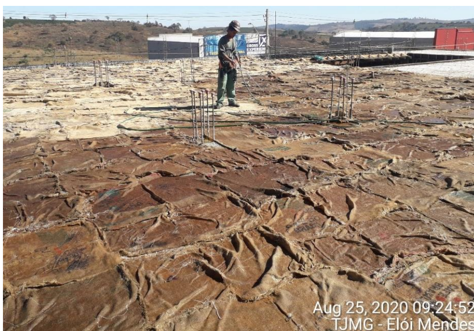
Figura 50: Cura do concreto utilizando sacos de aniagem.
