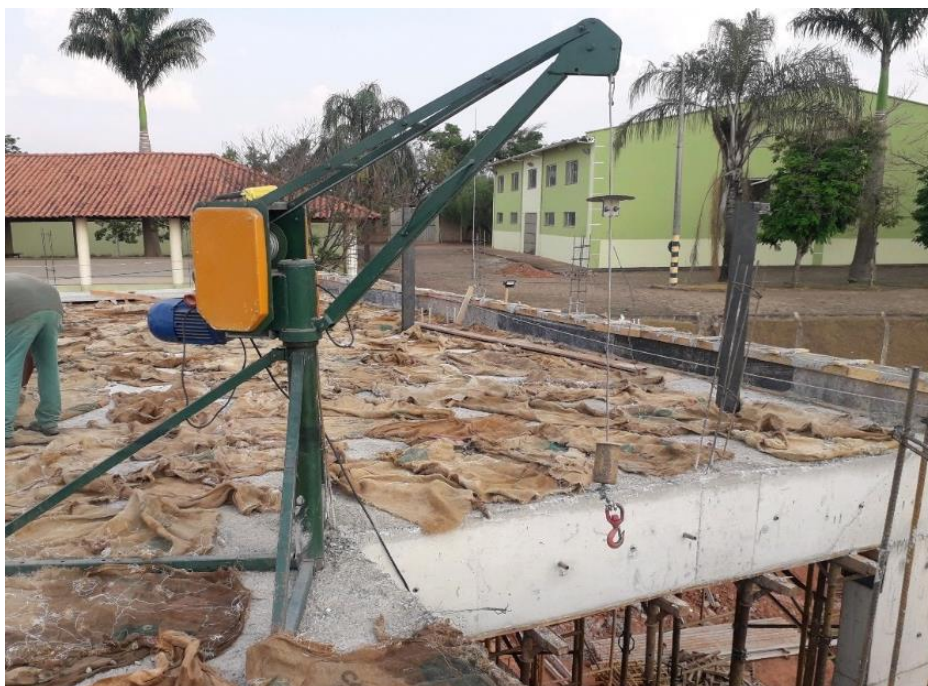
Figura 30: Mini-grua utilizada para transporte vertical de materiais e equipamentos.
