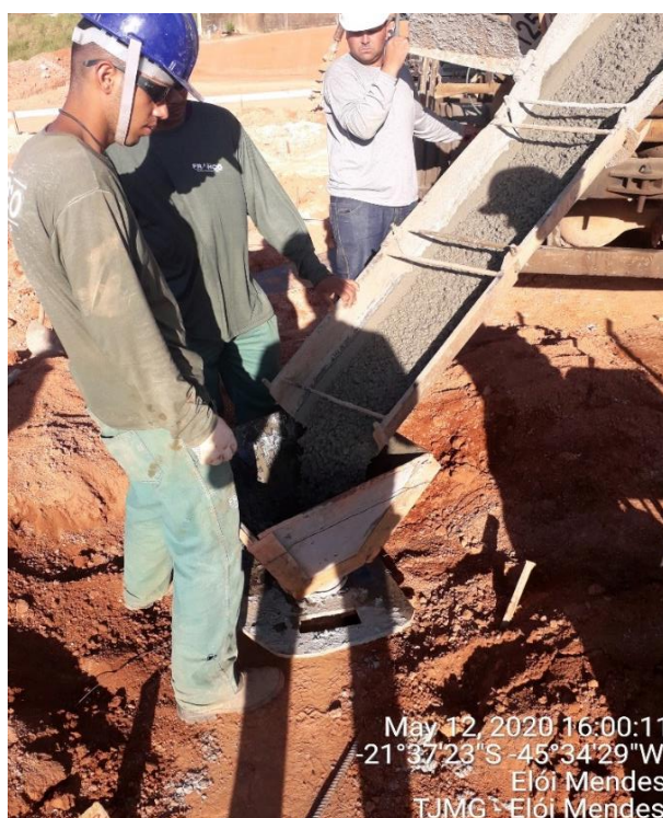
Figura 44: Concretagem das estacas com auxílio de funil de tremonha.
