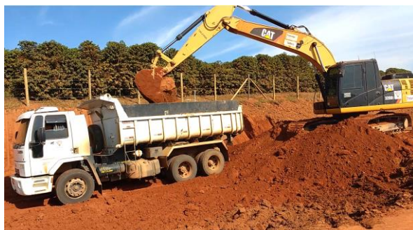
(a) Transporte do solo de empréstimo do aterro;
