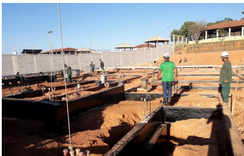
Figura 56: Baldrames impermeabilizados com emulsão asfáltica.
