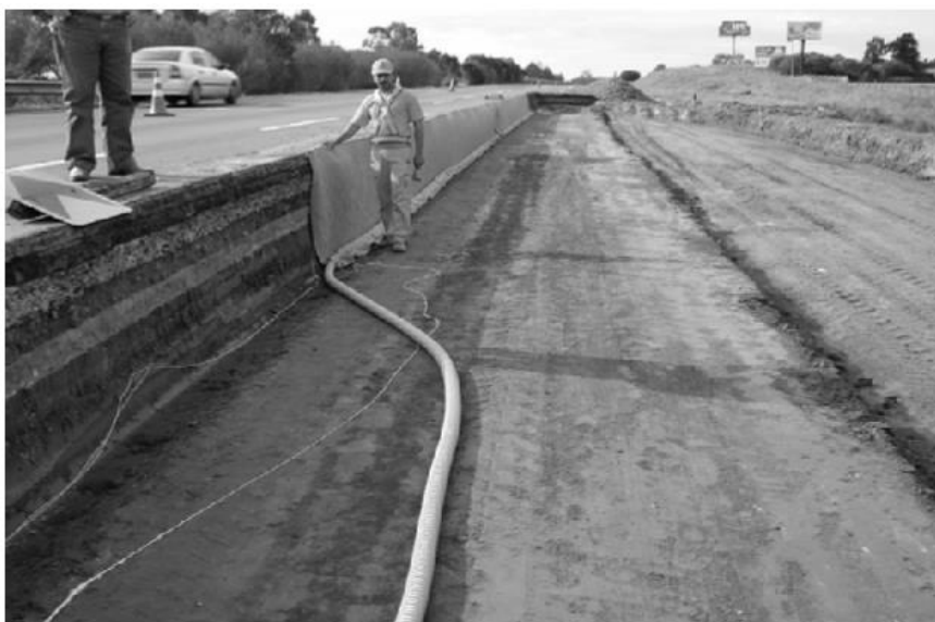
Figura 6-Execução de Geocompostos Drenantes
