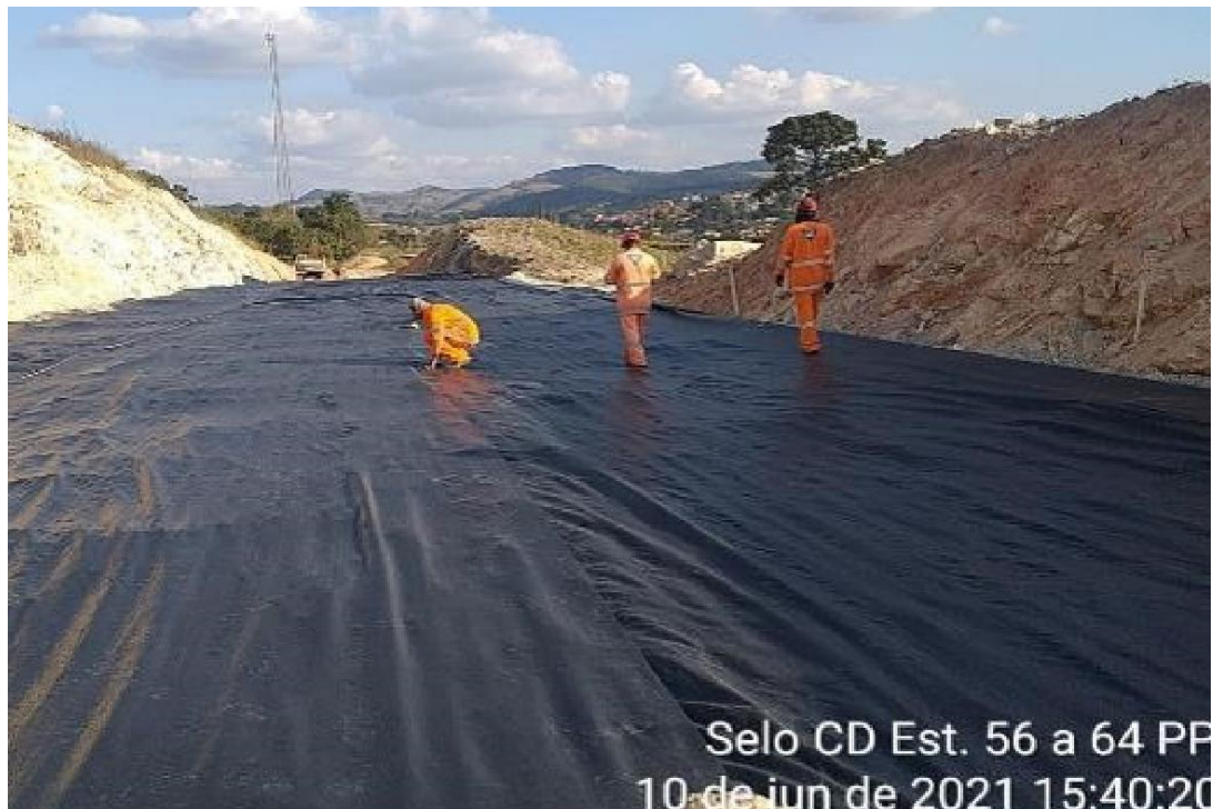
Figura 27- Execução de selo da camada de brita com manta geotêxtil de colchão drenante executado na obra de estudo de caso.
