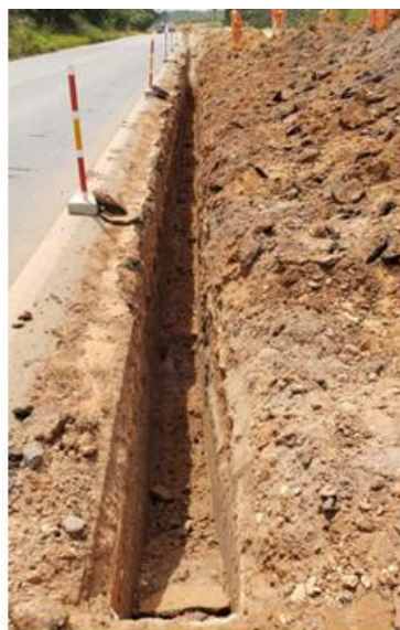
- Implantação de dreno tipo DPS-02 nas obras de duplicação da BR-304/RN.
