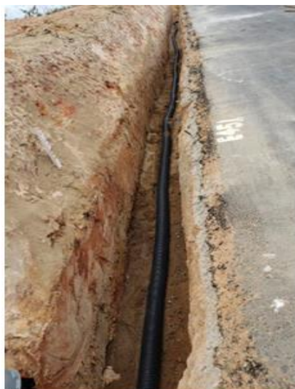
- Implantação de dreno tipo DPS-02 nas obras de duplicação da BR-304/RN.
