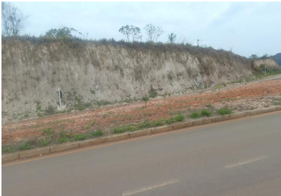
Figura 22- Talude Esquerdo continuação.
