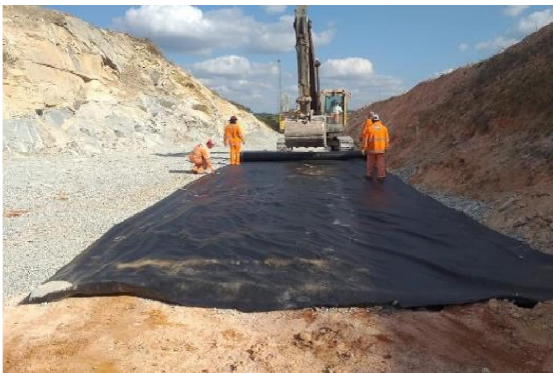
Figura 26- Execução de selo com manta geotêxtil da camada de brita do colchão drenante.
