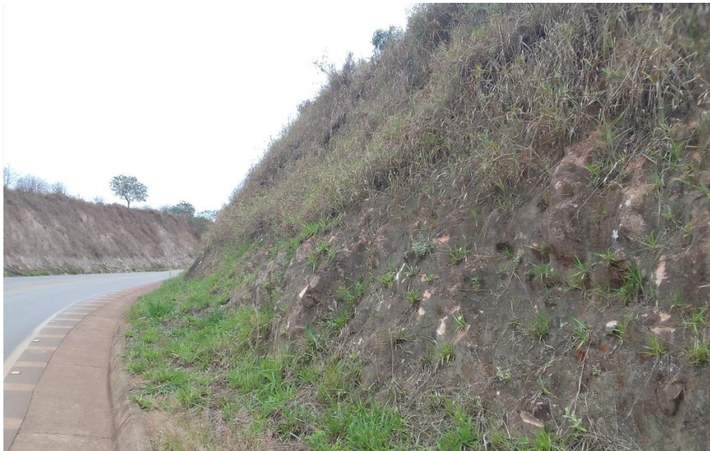
Figura 17-Talude executado lado Direito e DPS direito.
