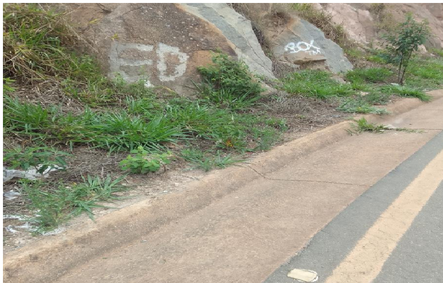
Figura 19-Execução de Dreno Longitudinal Profundo esquerdo
