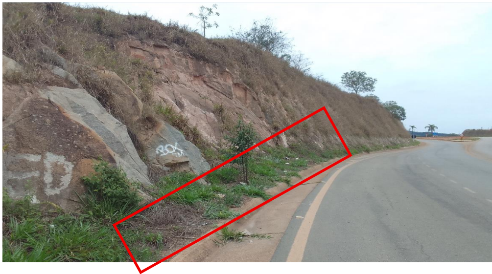
Figura 20- Dreno Longitudinal Profundo (DPS esquerdo) revestido com selo de grama, continuação.
