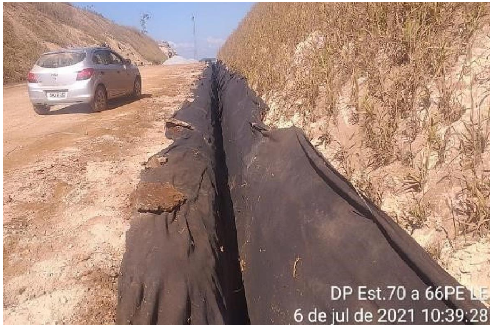
Figura 24- Dreno Longitudinal Profundo Esquerdo.
