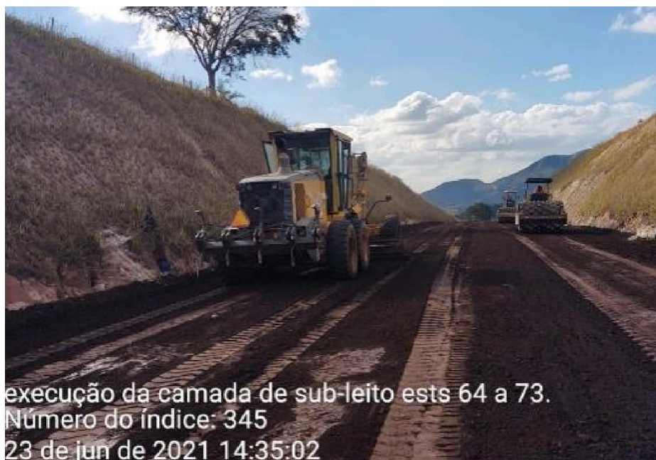
Figura 25- Execução da camada de Sub-leito.
