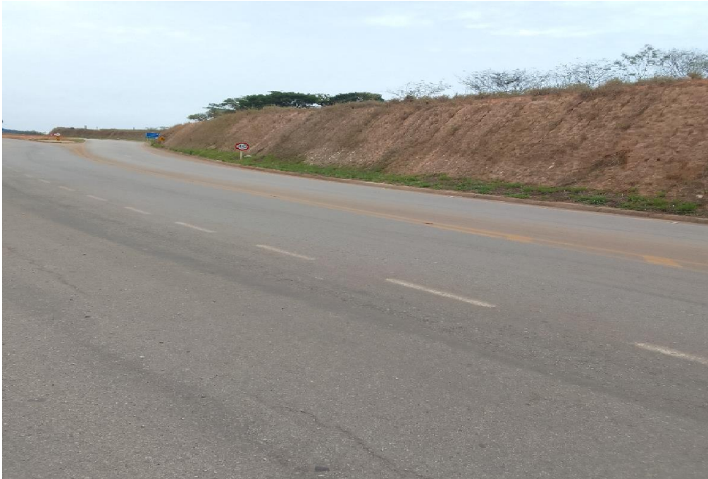
. Figura 21- Talude e Dreno Longitudinal Profundo lado direito da pista.
