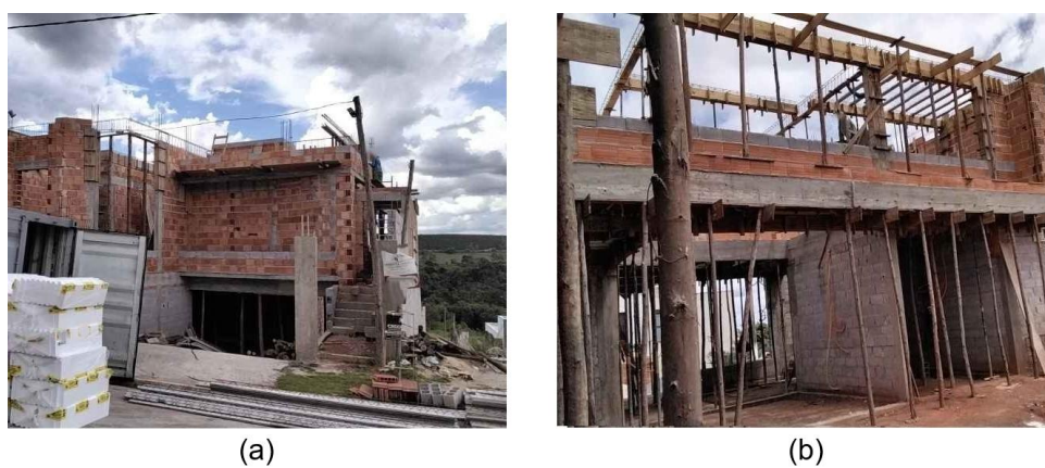
Figura 14: Registros de obras fiscalizadas. (a) Obra em alvenaria estrutural e em preparo para laje. (b) Obra em concretagem e escoramento, com pilares, vigas e formas moldadas para laje superior.
