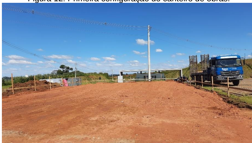
Figura 12: Primeira configuração do canteiro de obras.
