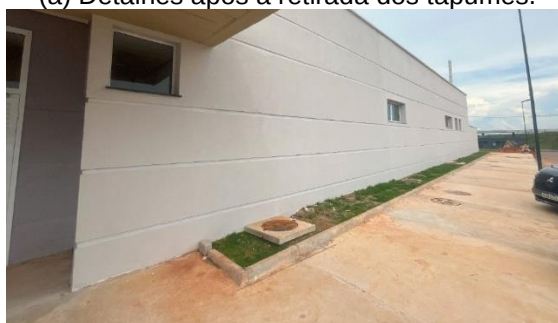
(b) Detalhes da obra em fase de finalização.
