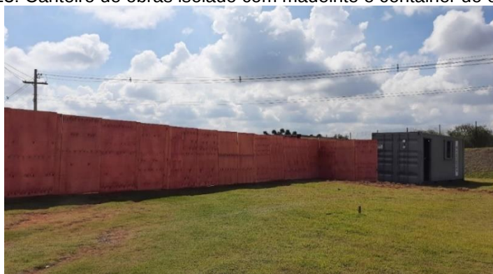
Figura 13: Canteiro de obras isolado com madeirite e container do escritório.
