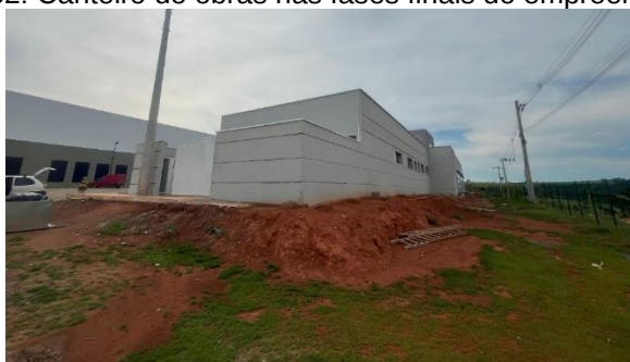
(a) Detalhes após a retirada dos tapumes.
