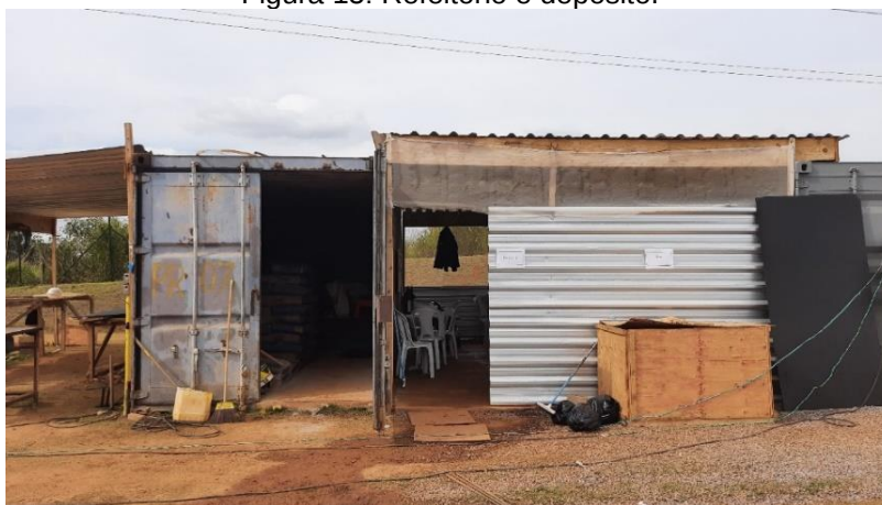
Figura 15: Refeitório e depósito.
