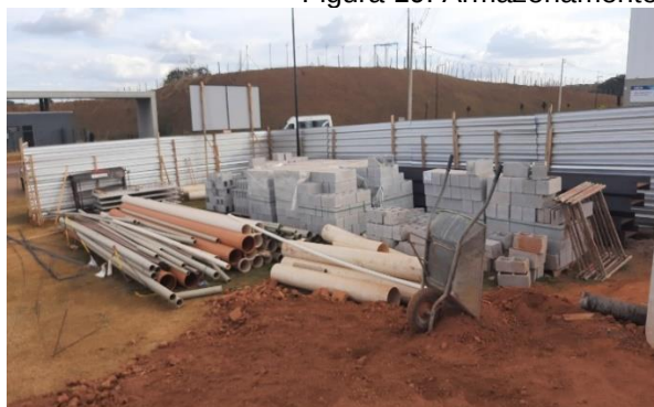
(a) Entrada da obra.
