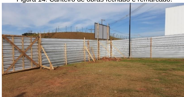
Figura 14: Canteiro de obras fechado e remarcado.
