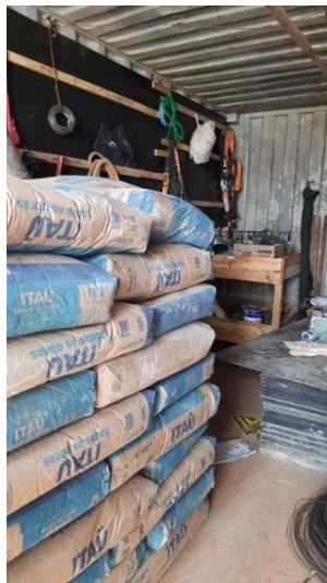
Figura 18: Armazenamento de materiais perecíveis em container.
