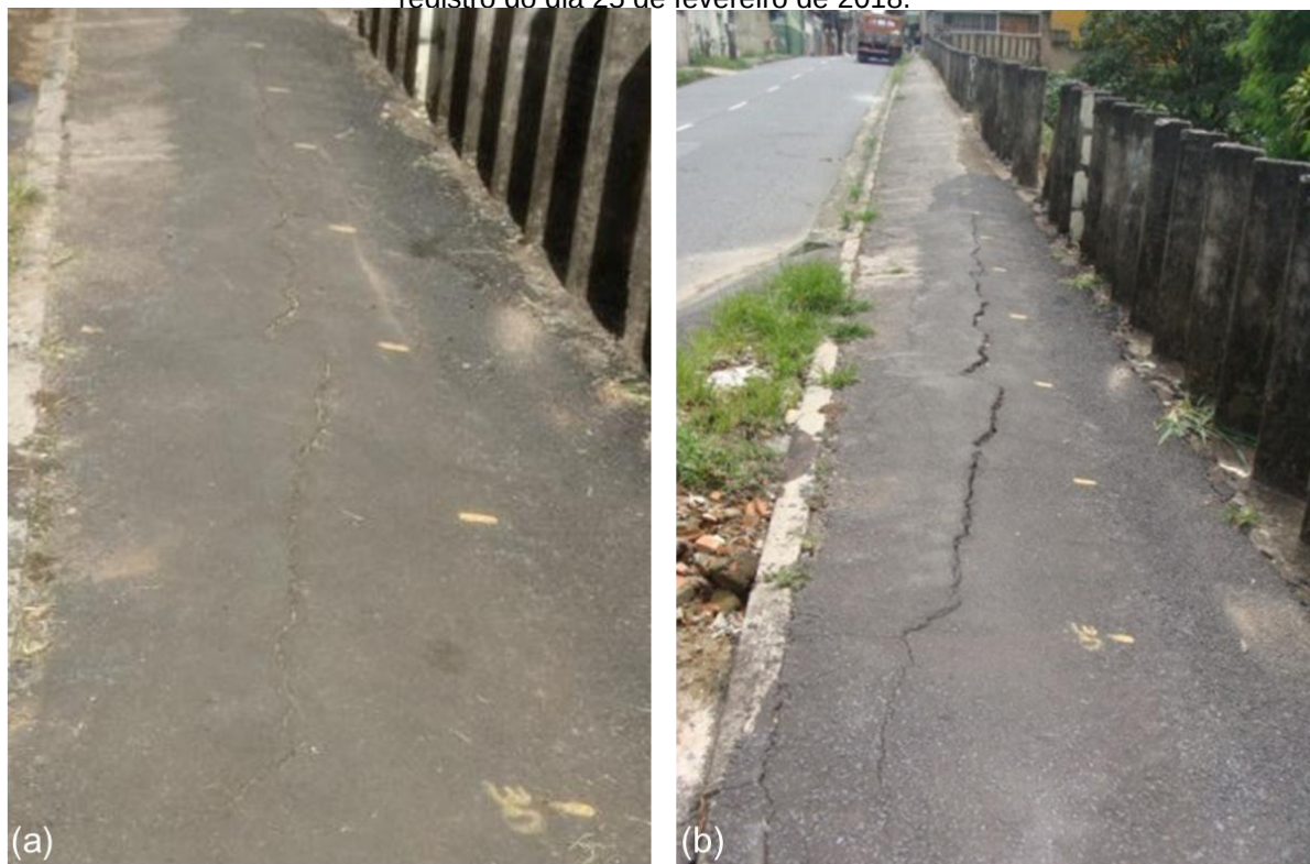
Figura 8: Evolução de uma rachadura na calçada: (a) registro do dia 19 de janeiro de 2018; (b) registro do dia 25 de fevereiro de 2018.
