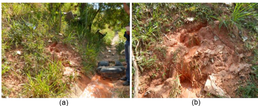
Figura 10: Vista do ponto de saída das águas lançadas e seu escoamento sobre a canaleta intermediária (a) e vista aproximada do ponto de saída das águas lançadas (b).
