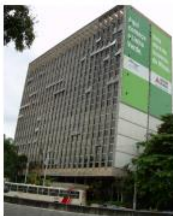
Figura 27 – Vista do edifício DER/MG.
